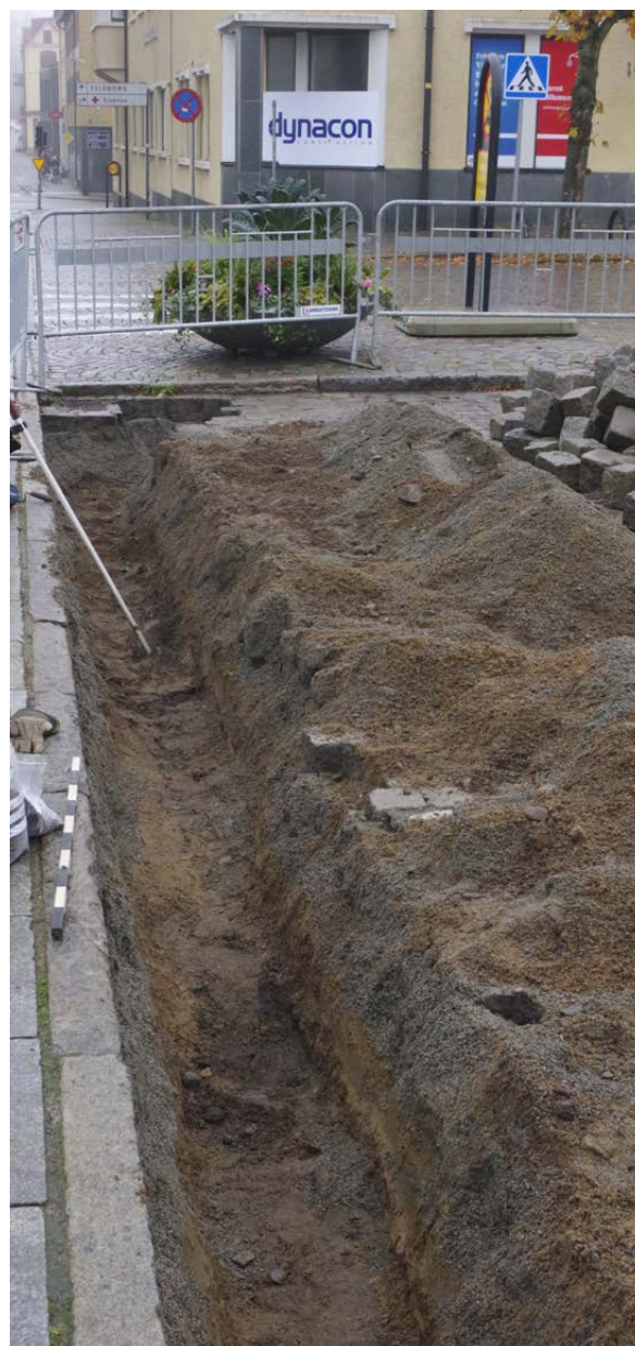
Figur 16. Lager 24 i schakt 12. Från väster.
