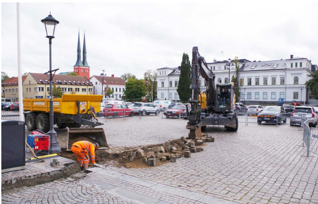
Figur 6. Arbetsbild. Schaktning av det nordvästra området. Från nordväst.
