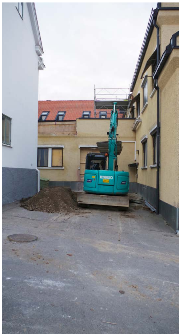
Figur 5. Schaktning med maskin. Från söder. Foto: Kalmar läns museum
