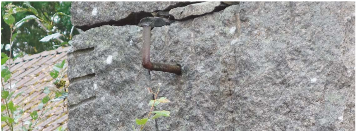
Rundjärn med rätvinkligt hörn, instucket i ett borrarat hål.
