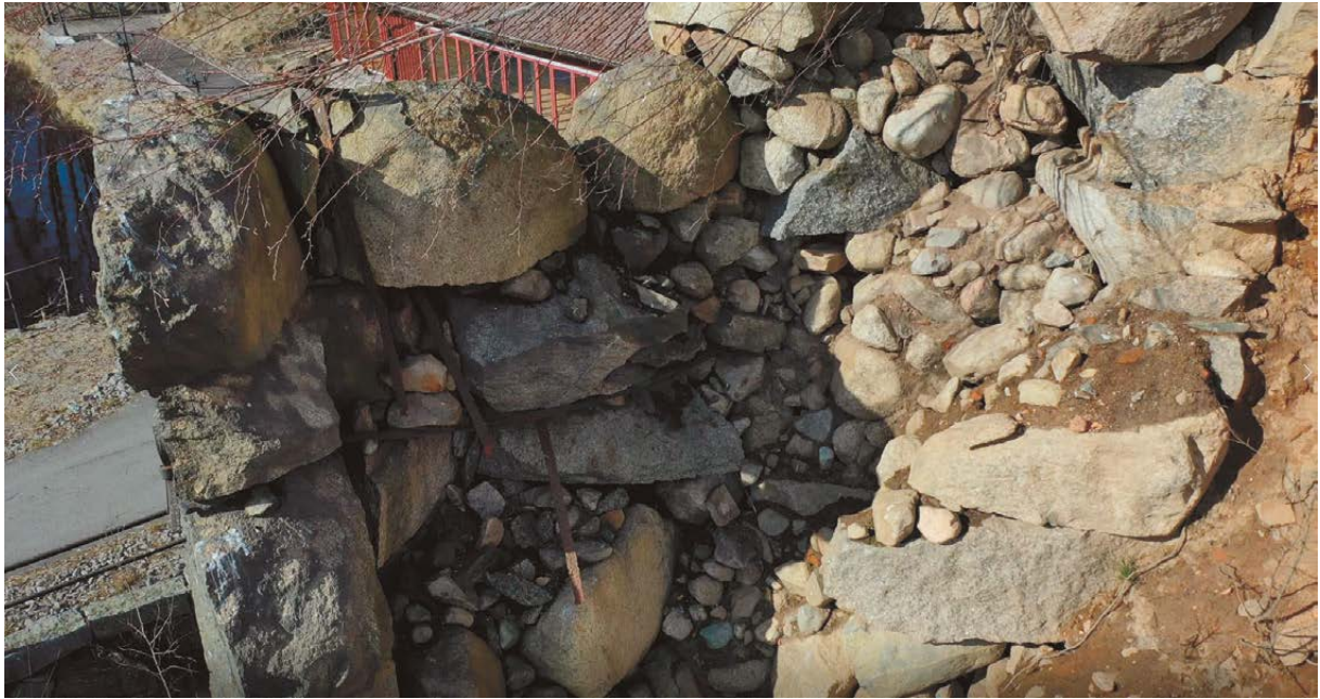
Fyllnadssten innanför mantelmuren bestående av mindre rundade stenar. Dessa har troligen använts som utfyllnad mellan mantel och den inre muren mot pipan.
