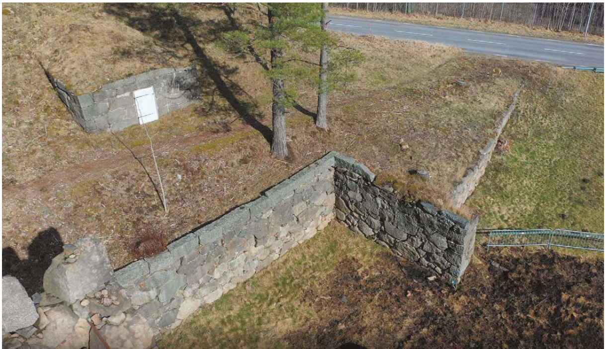
Översikt av muren nordöst och öst om masugnen. Uppe till vänster syns även en murad källare, denna markeras ej på äldre kartor.
