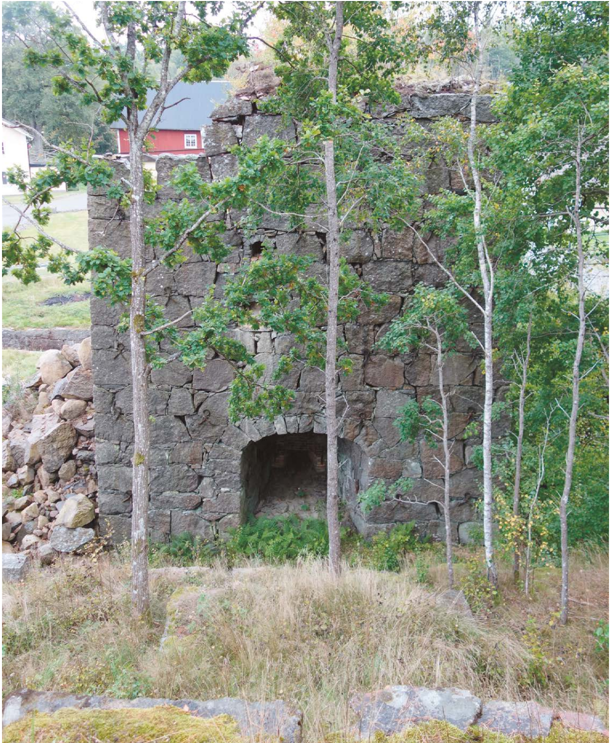
Masugnen sedd från nordöst och den äldre körbrons sockel. Bakom träden till höger skymtar masugnens ursprungliga höjd.
