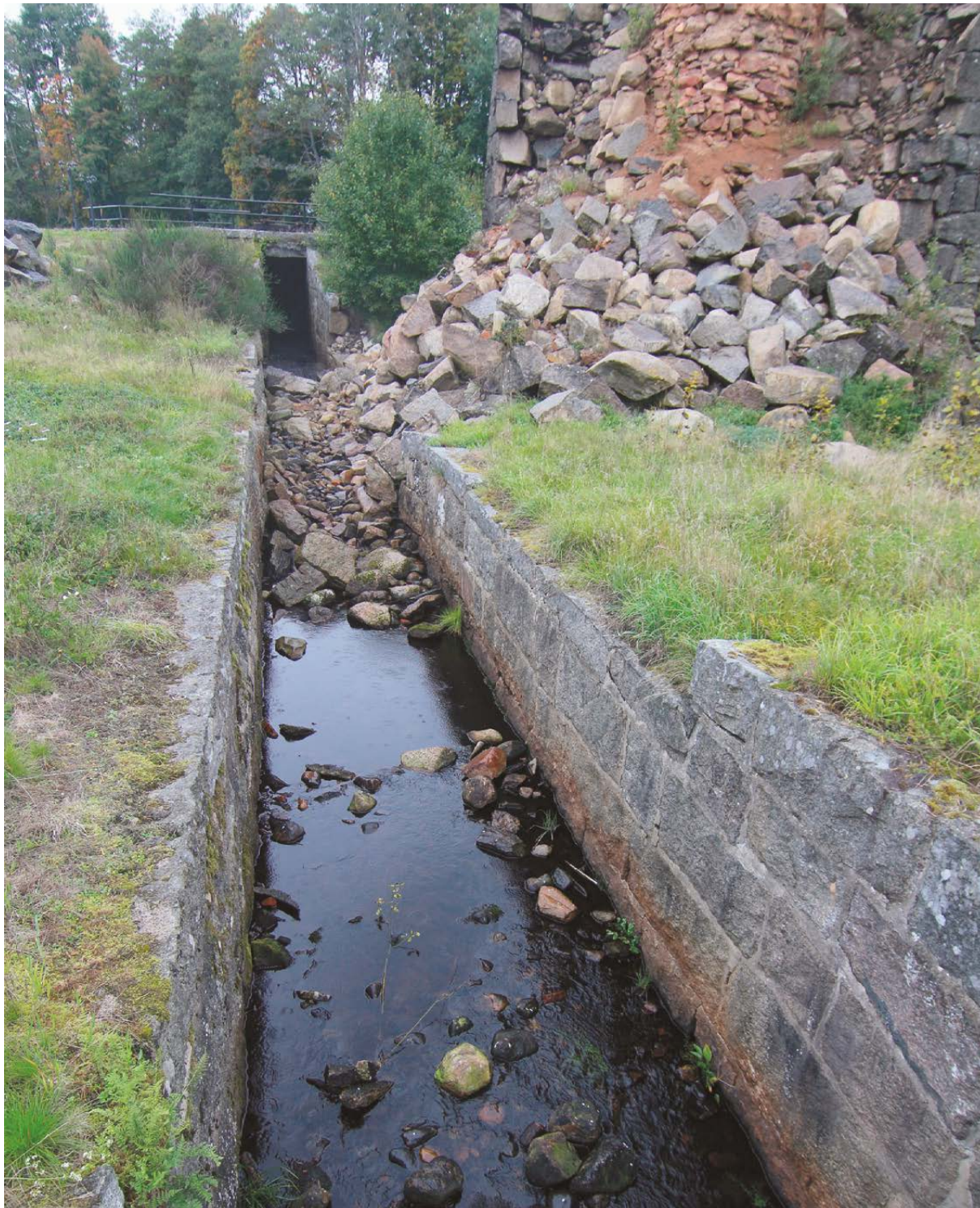
Kanalen sedd från sydöst. Stenarna är mycket välbuggna och släta i kanalen. Dessa har fogstrukits med betong i efterhand.
