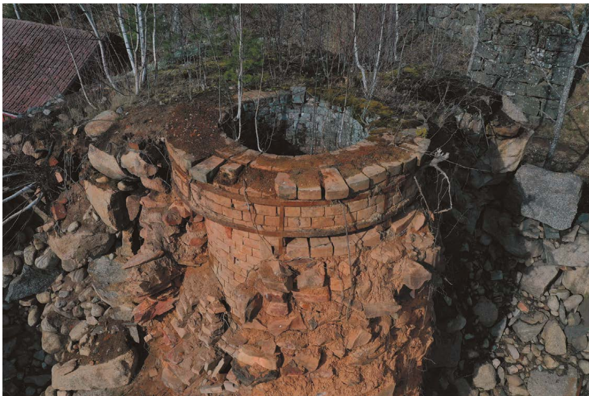
Pipan sedd från ovan. Här ser man att krönet är två helstenar tjockt, det översta skiftet ligger löst på krönet.
