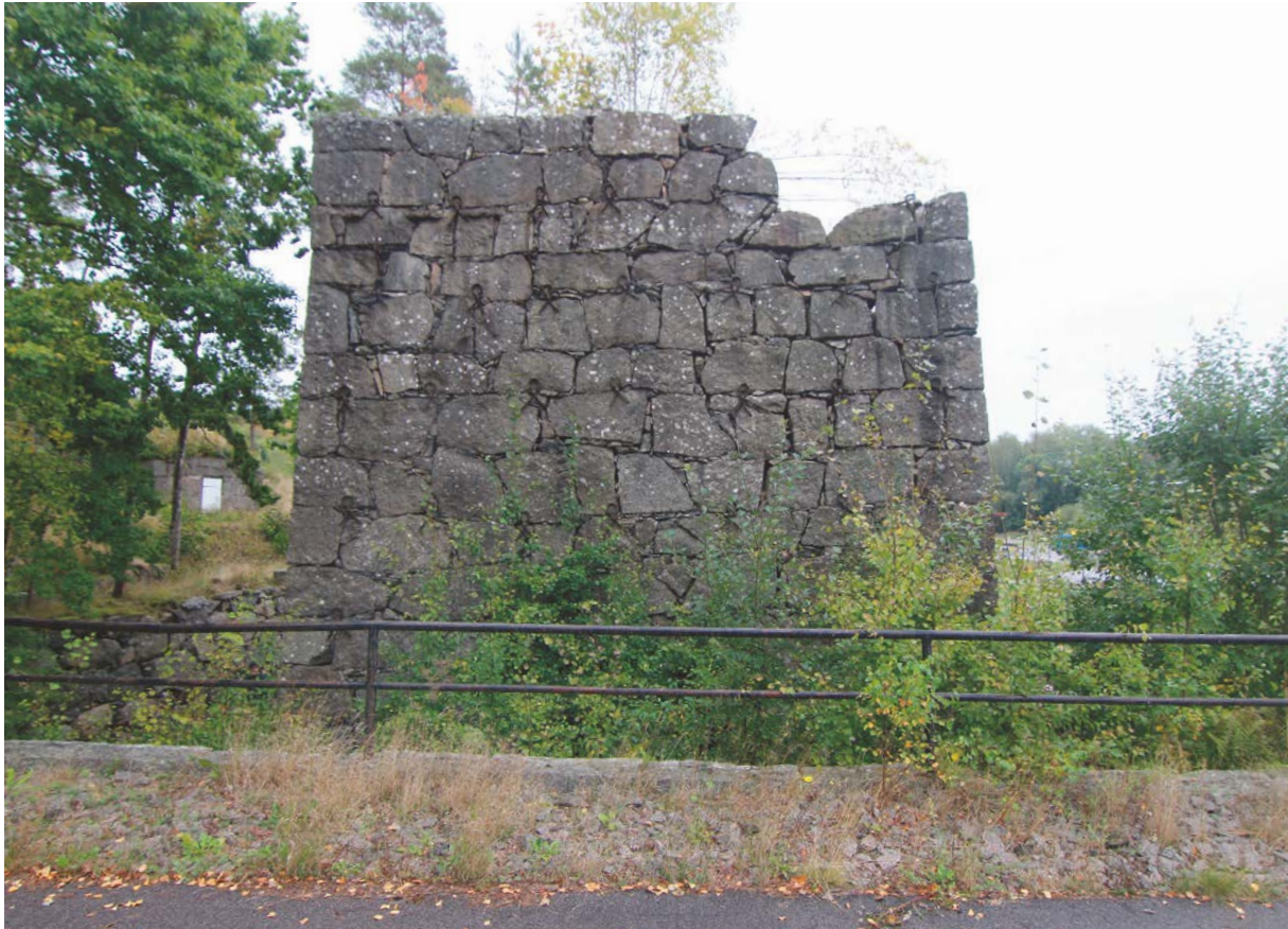
Den nordvästra fasaden är till stor del intakt. Fotografiet är taget från dammvallen i nordväst, marken mellan dammen och masugnen är kraftigt bevuxet med sly och fasaden är svår att urskilja i marknivå.
