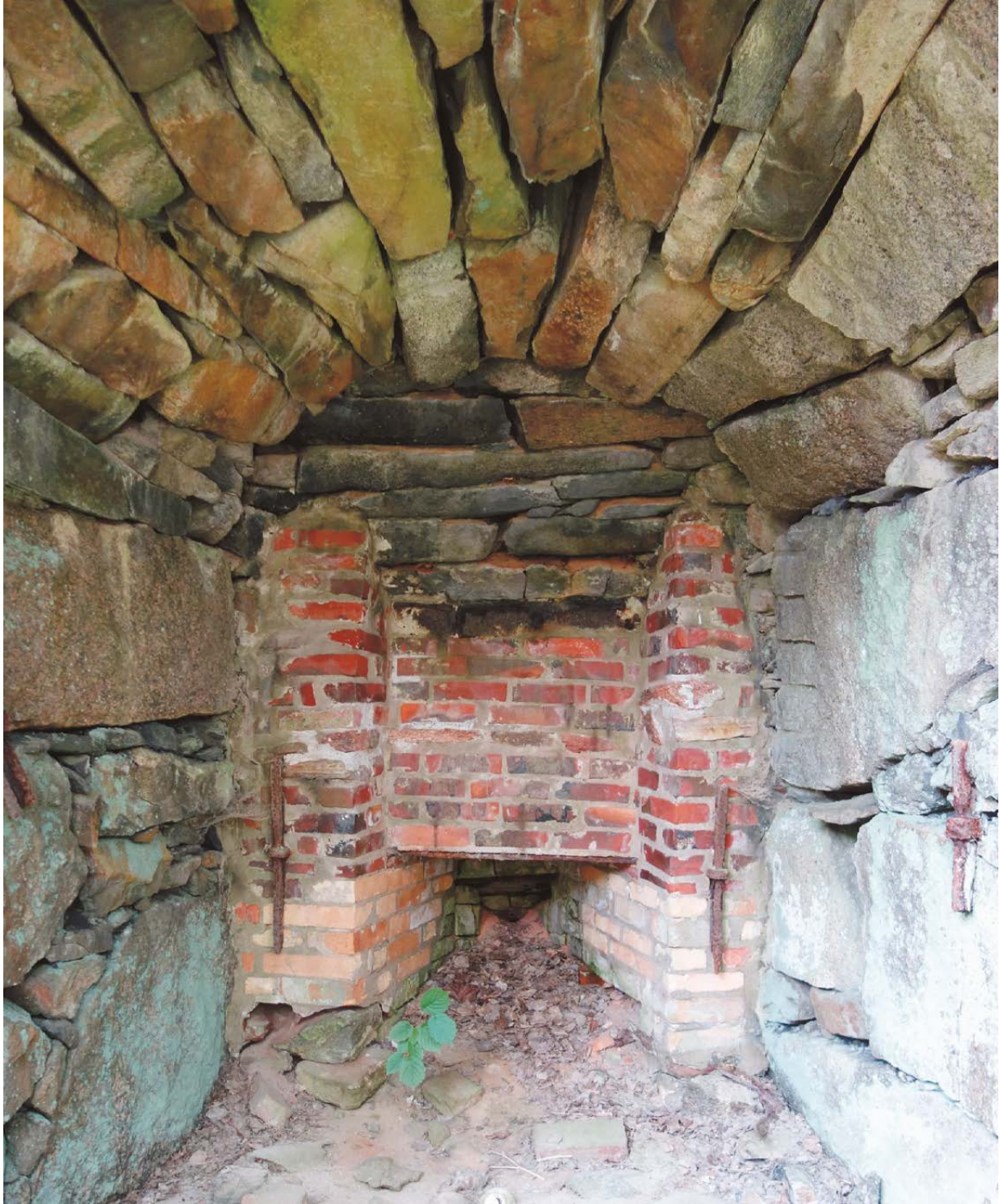
Tegelkonstruktion i botten av öppningen i den nordvästra fasaden. De övre- och nedre skiften skiljer sig åt i kulör, troligen även i ålder.
