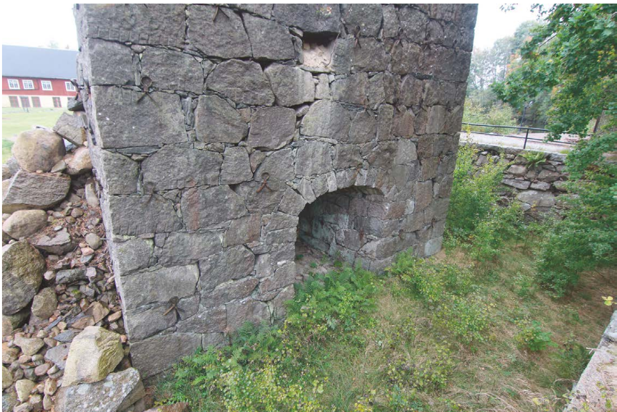
Masugnens nordöstra fasad med kallmurad mantelmur, välvd öppning i marknivå samt en mängd ankarlut i murverket.
