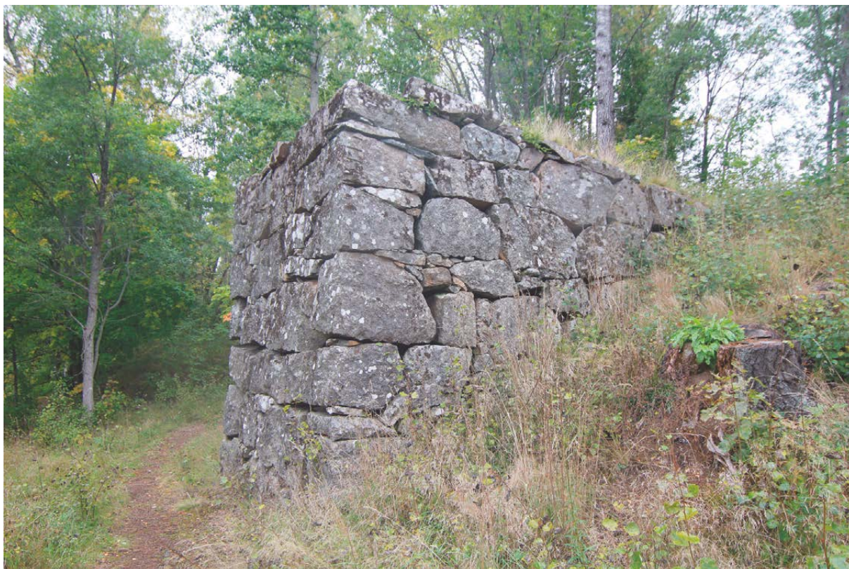
Körbrons fundament norr om masugnen.
