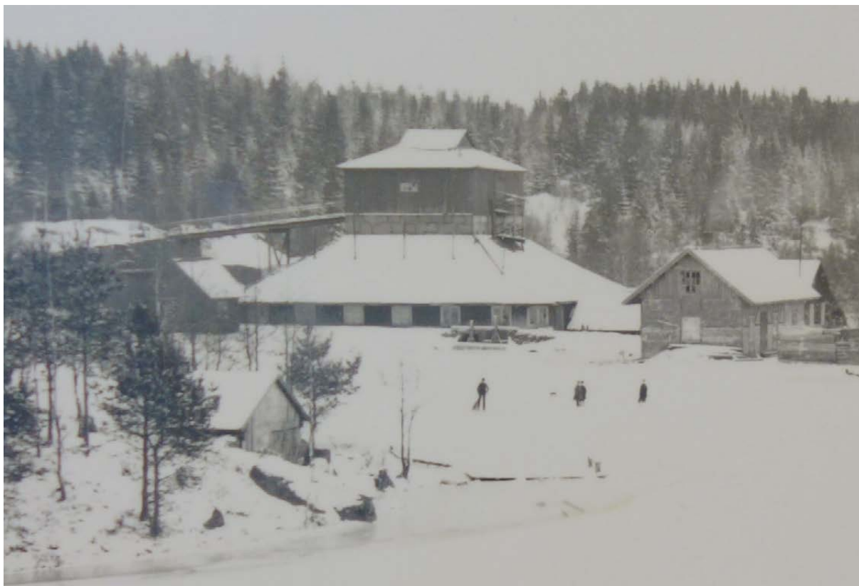
Utdrag ur fotografiet ovan, här syns masugnens utformning med överbyggnad, tak och kringliggande träbyggnad. Här syns även körbron upp till masugnens krön. Framför masugnbyggnaden syns dammluckor till rännan för blåsmaskinens drift (Kronobergsarkivet).
