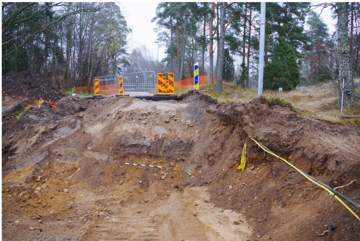
Figur 7. I den östra sidan av det breda schakt som togs upp hösten 2024 syntes en äldre marknivå som var bevarad under Skirvägens sentida bärlager. Foto taget från väster.
