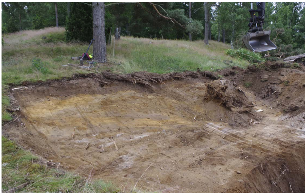
Figur 5. Inom schakt 1 gjordes en skiktvis avbaning ned till en nivå av 0,5 till 0,8 meter under tidigare markyta, Foto taget från väster.
