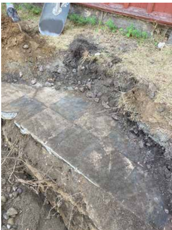
Figur 11. Golvet påträffades i norra delen av schaktet och låg intill husväggen. Fotograferat från sydväst.
