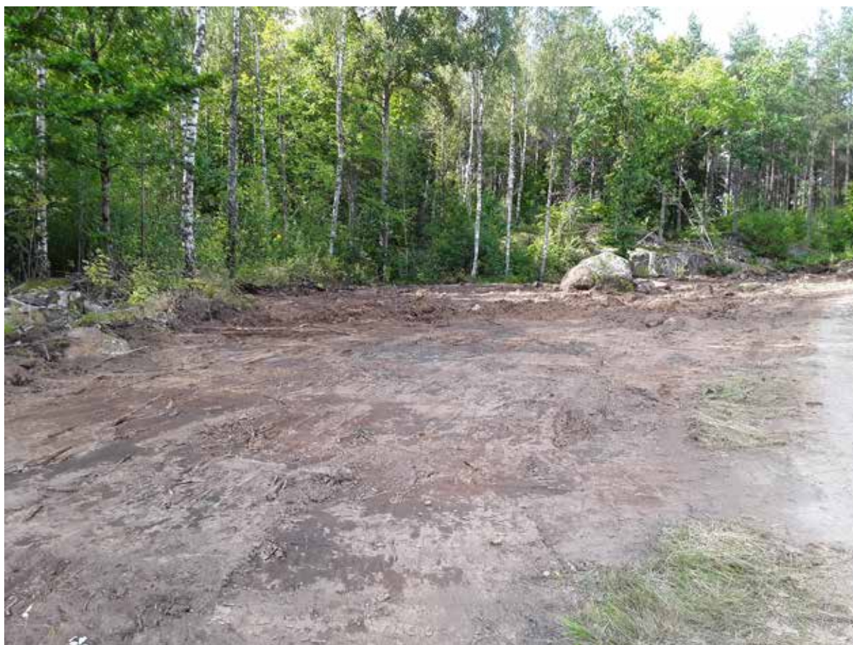
Figur 12. Översikt över den schaktade, schakt 10, ytan från N
