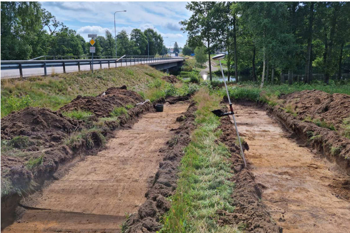
Figur 6. Delar av två schakt. Foto från NV.
