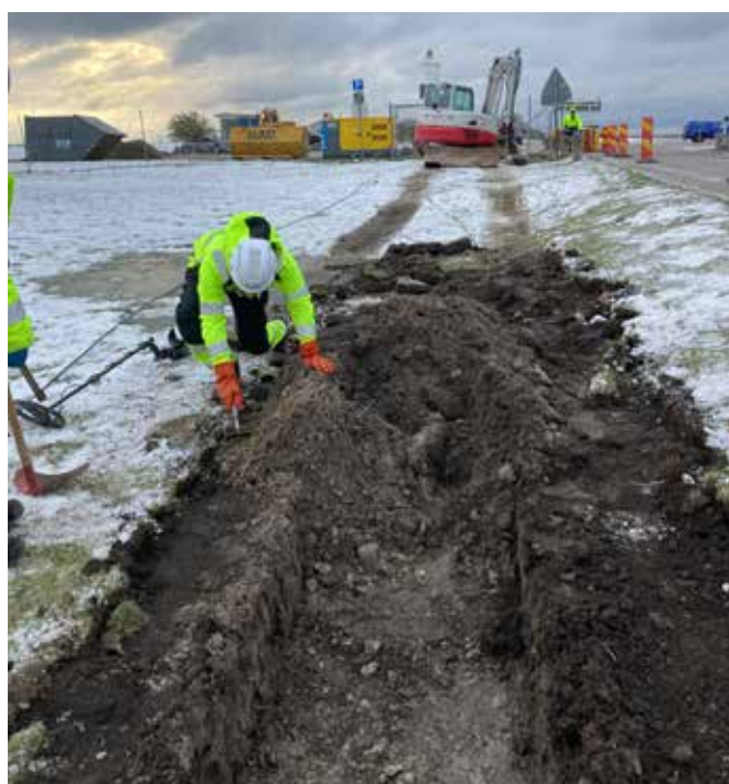
Figur 6. Handrensning i norra schacket område 1. Fotograferat från norr.
