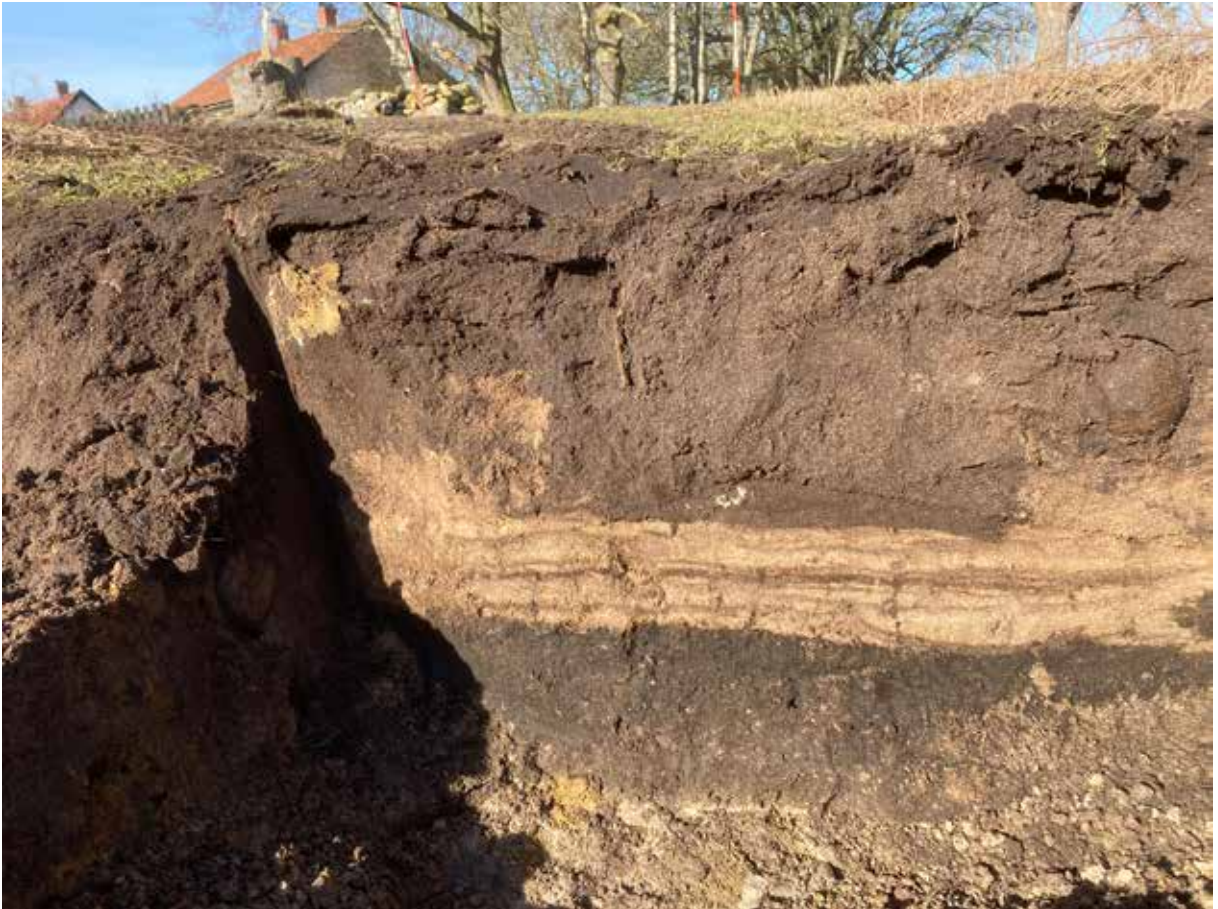
Figur 20. Profilen i det norra schaktet inom område 5. Fotograferat från öster.
