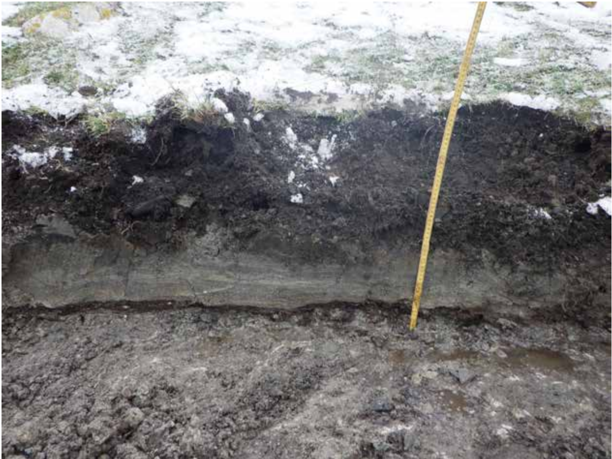
Figur 7. Stratigrafin i det norra schaktet inom område 1. Fotograferat från öster.
