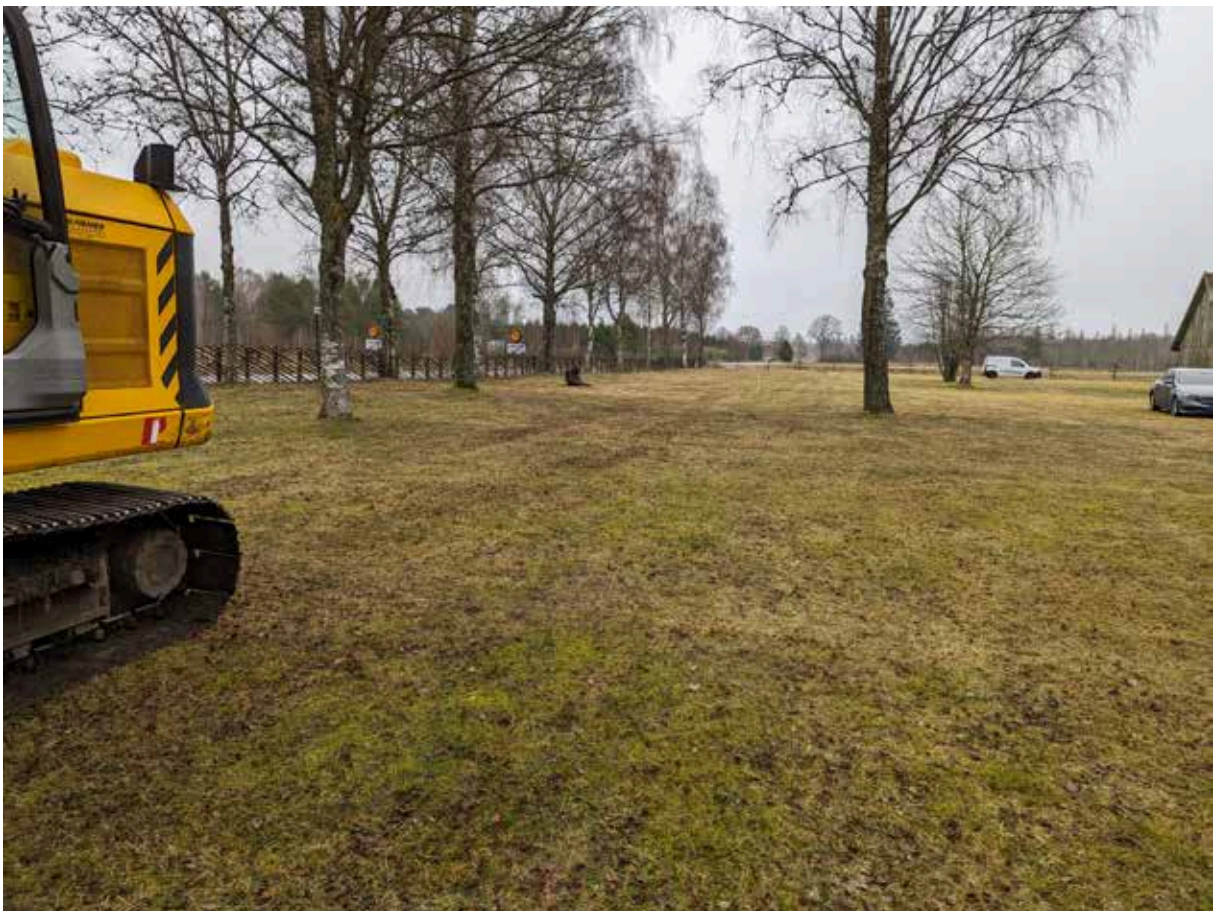
Figur 4. Platsen innan schaktning. Foto från NNV
