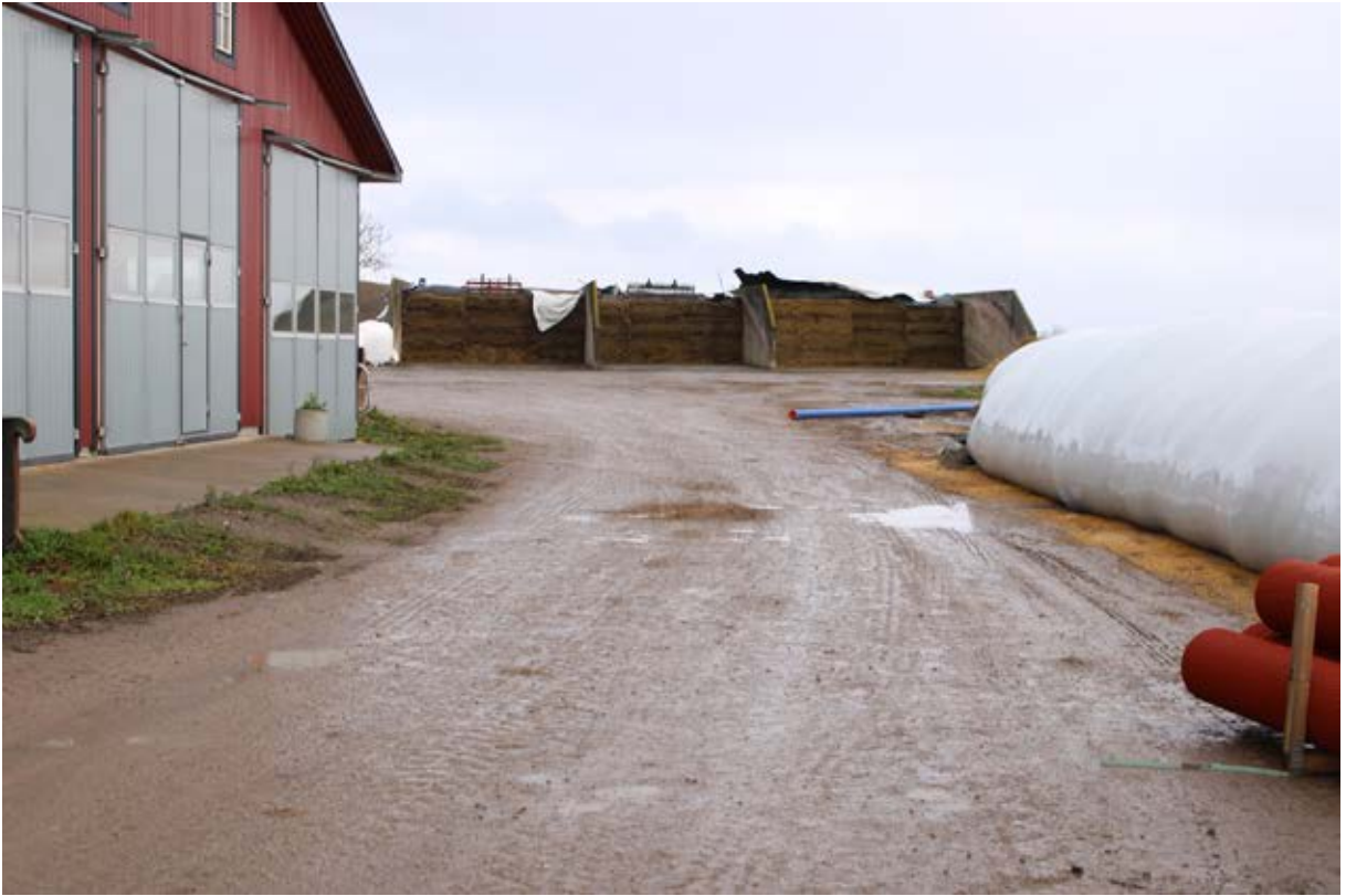
Figur 6. Den hårdgjorda ytan söder om ladugårdsbyggnaden schaktades i november. Foto från V
