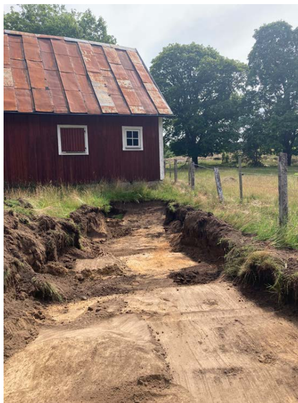
Figur 5. Schakt i områdets sydöstra del. Matjorden följdes av en sandig silt. Fotograferat från öster.
