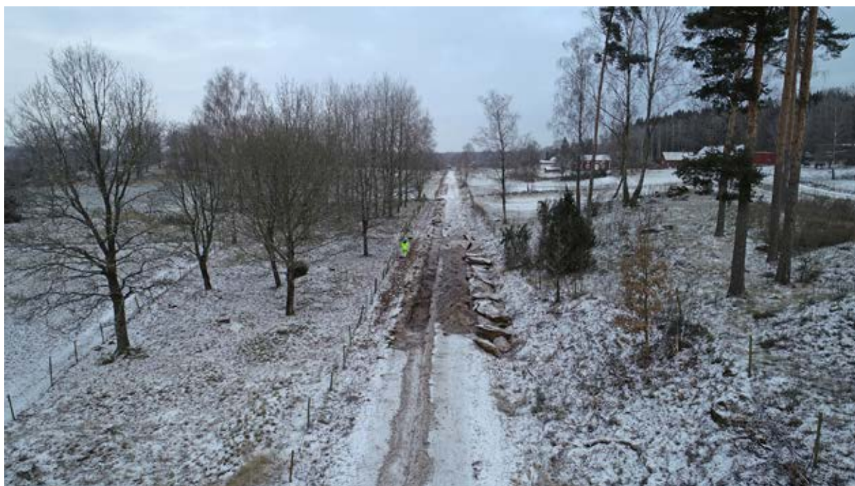
Figur 7. Översiktsbild med pågående schaktning vid gravfältet L1954:6044. Foto från S.
