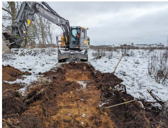
Figur 3. Schaktning och rensning. Foto från sydväst.
