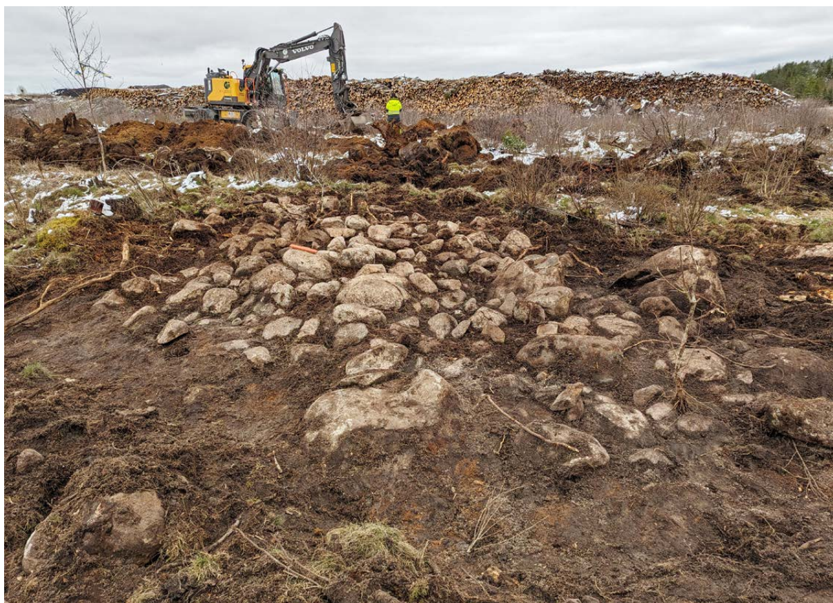
Figur 9. Avtorvad yta av röjningsröse A2. Foto från sydväst.
