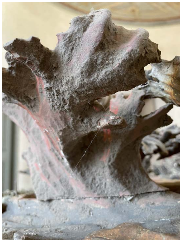
Smutsigt ytskikt före åtgärd, detalj. Lumpapper skymtas i skarven.
