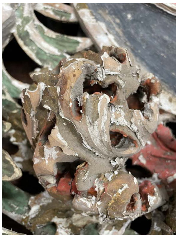
Detaljbild, spjälkning flagning.
