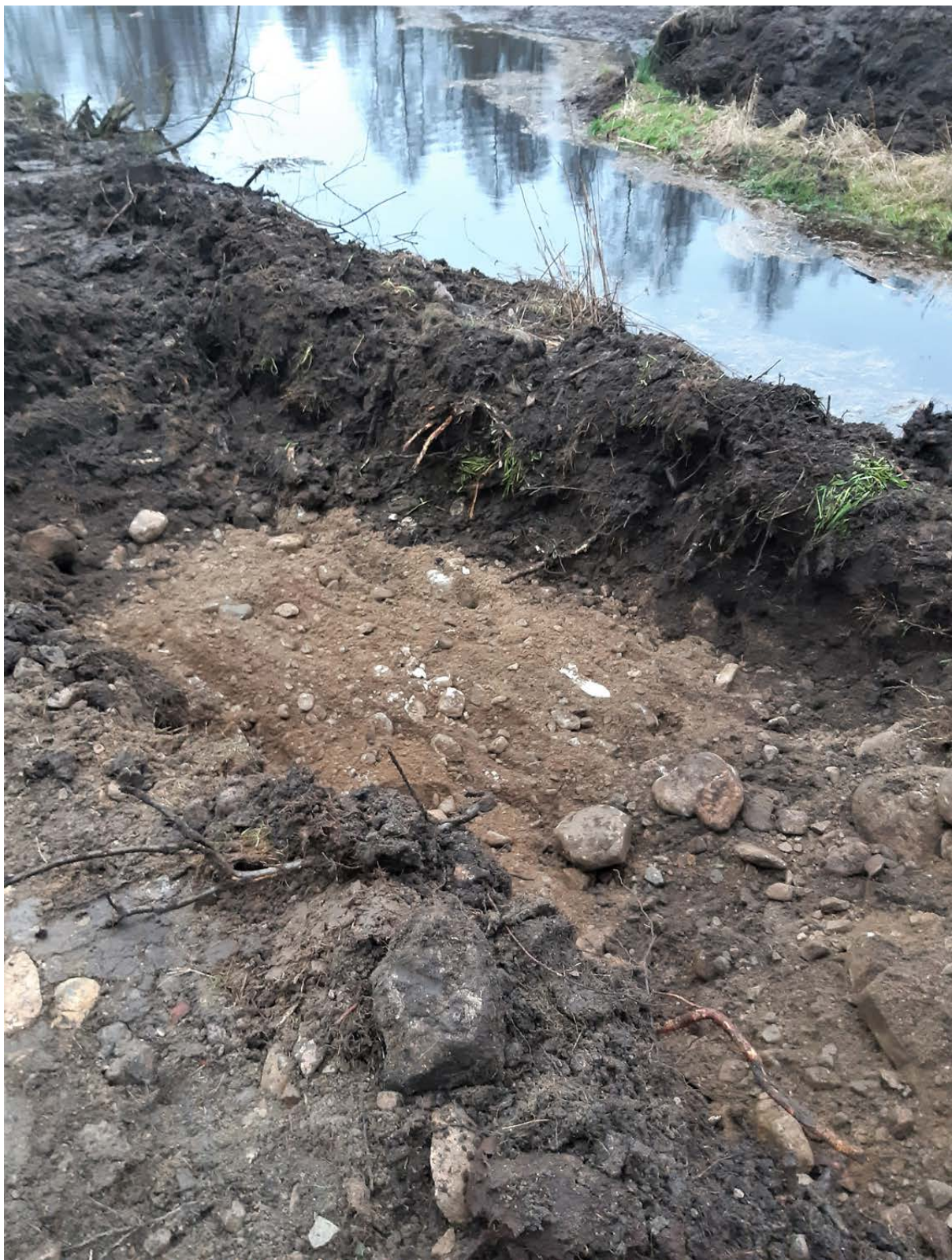
Figur 13. En del av schakt 2 under arbete. Bottenmaterialet var en grusigt siltigt med inslag av sten. Speciellt i de nordvästra delarna av schaktet där det gick djupare in i åsen. I de sydöstra delarna var materialet mer gråaktig silt. Foto mot SO.
