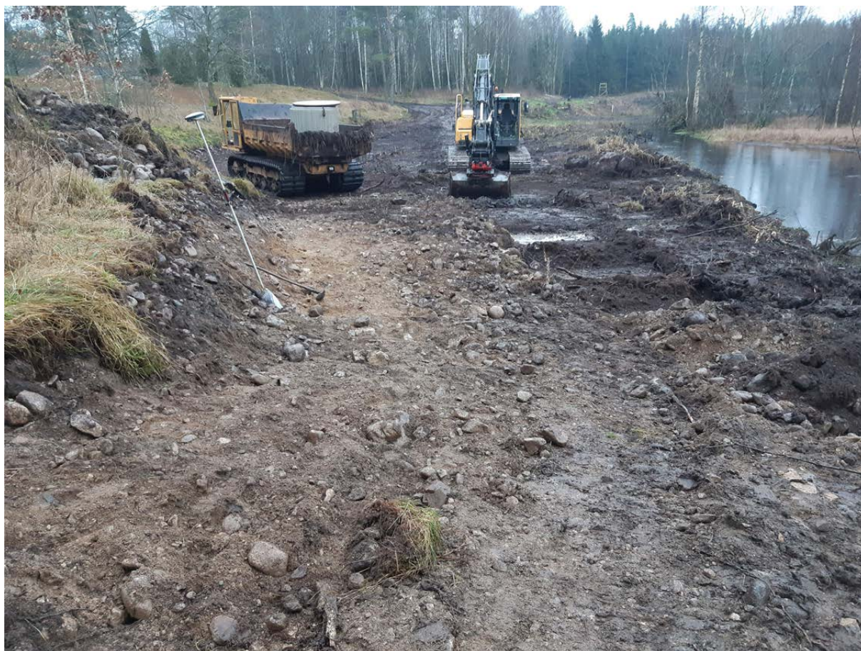
Figur 14. För schakt 3 planades en del av åsslutningen i områdets nordvästra del ut. Foto mot SO.
