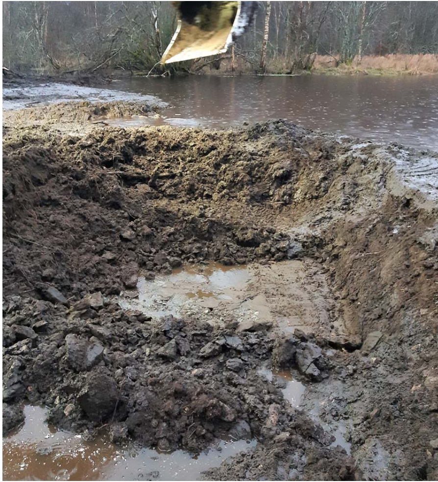
Figur 8. En stor del av undersökningsområdet, vilket låg i den gamla sjöbasängen, var fortfarande vattensjukt och undersöktes genom att en vall av torv och lera schaktades upp som höll vattnet borta medan platsen undersöktes. Det var tekniskt utmanande och riskfyllt. Här syns en del under arbete. Foto mot SV.
