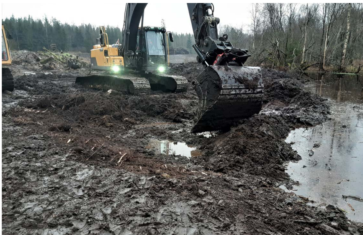
Figur 20. Några av de metodologiska utmaningar schaktningsövervakningen bjöd på. Det var möjligt att genomföra skiktvis avschaktning av torv och annat material, men det blev snabbt svårt att övervaka, samt hantera vatten och gröten av torv och lera. Foto mot SO.
