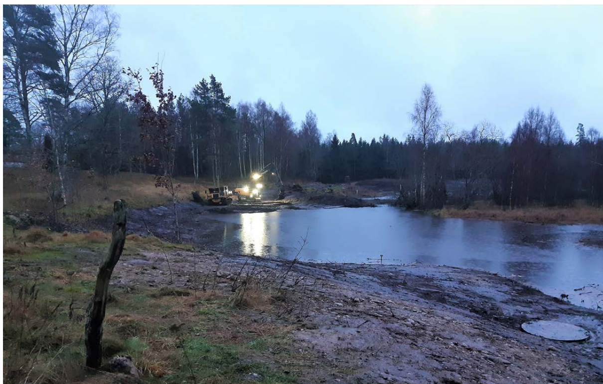
Figur 22. Undersökningsområdet när stora delar av vattenspegeln återskapats. Endast det oövervakade området A66 i bakgrunden är fortfarande under arbete. Den nyinstallerade brunnen för vattenkontroll syns i förgrunden th. Foto mot OSO.
