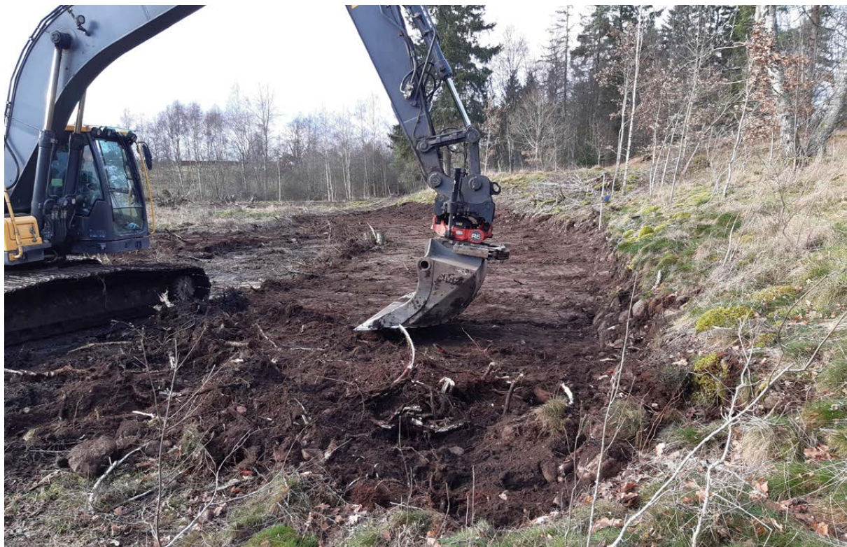
Figur 7. I ett första steg planades åskanten ut för att skapa en körväg för grävmaskin och dumper (linje 4). Foto mot NV.
