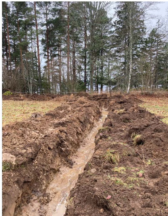
Figur 7. Schaktet vattenfylldes snabbt. Fotograferat från öster.
