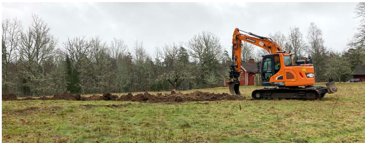
Figur 6. Schaktningsarbetet var förlagt till äldre åkermark strax väster om Målajords soldattorp, som här syns i bakgrunden. Fotograferat från nordväst.
