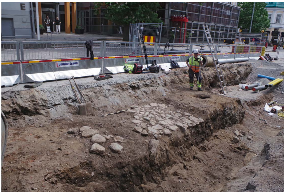
Figur 69. Rester efter den stenlagda Fånghusgatan påträffades i undersökningsområdets norra del. Foto taget från nordväst.
