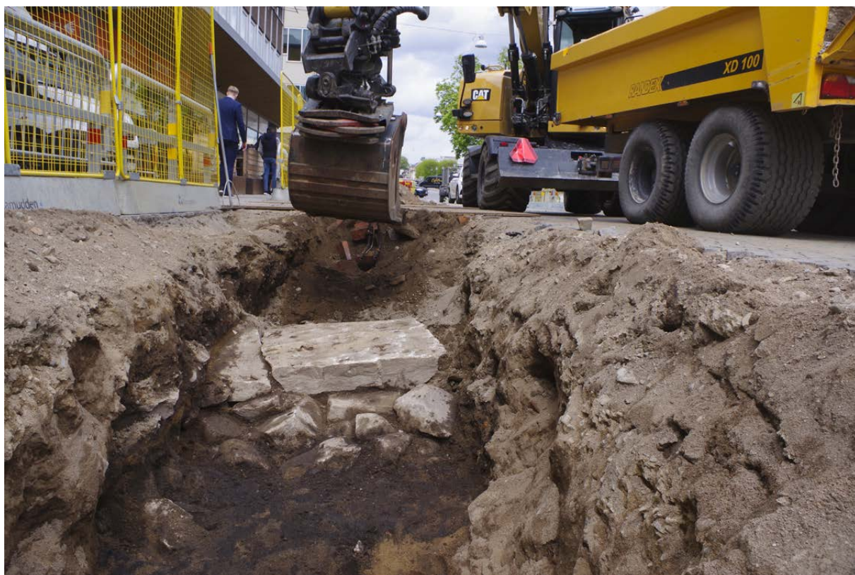
Figur 67. I undersökningsområdets södra del fanns en täckt kulvert byggd av stenhällar där man ledde om Snickarbäckens vatten vid ombyggnaden av gatan efter 1843. Foto taget från söder.
