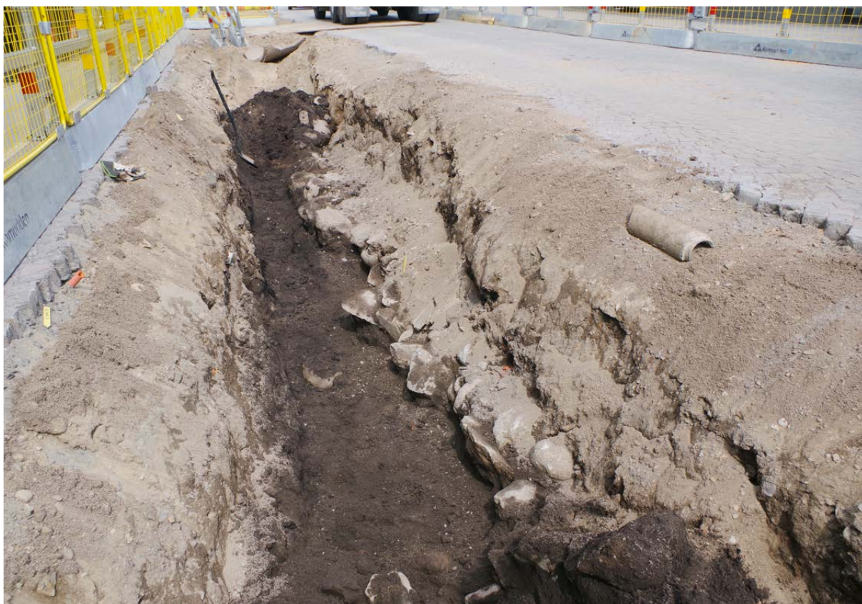
Figur 20. Stenpackningen A19 i den östra sidan av schaktet. Foto från sydväst.
