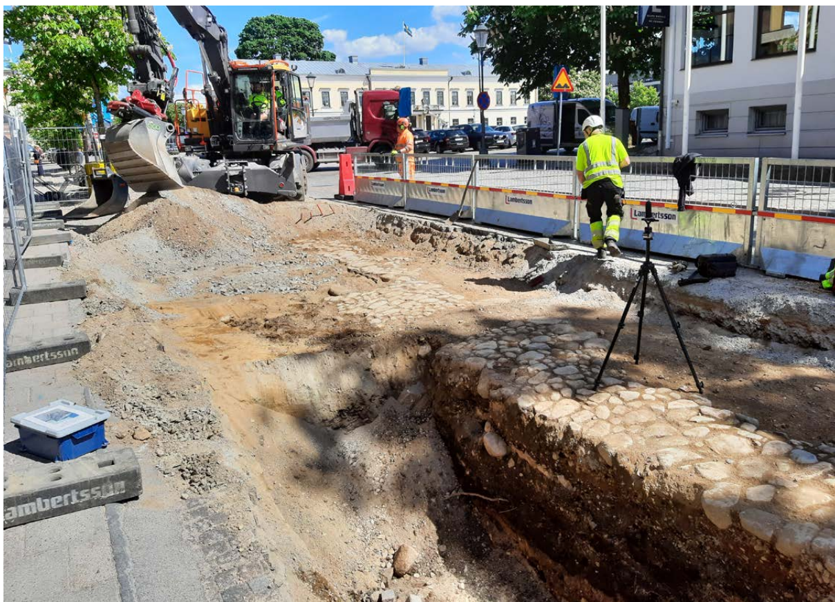
Figur 14. De delar av schakten som innehöll bevarade lämningar grävdes skiktvis omväxlande med grävmaskin och för hand. Bild från undersökningsområdets norra del med en del av den stenlagda gatunivån A36 frilagd. Foto taget från sydväst.
