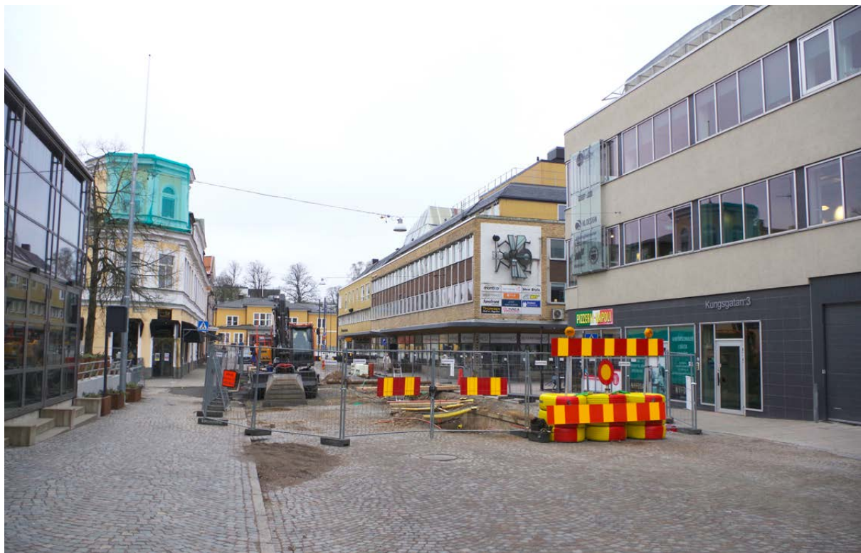
Figur 5. Undersökningsområdet berörde Kungsgatan södra del i centrala Växjö. På bilden pågår schaktningsarbetet i korsningen mot Sandgårdsgatan. Foto taget från norr,
