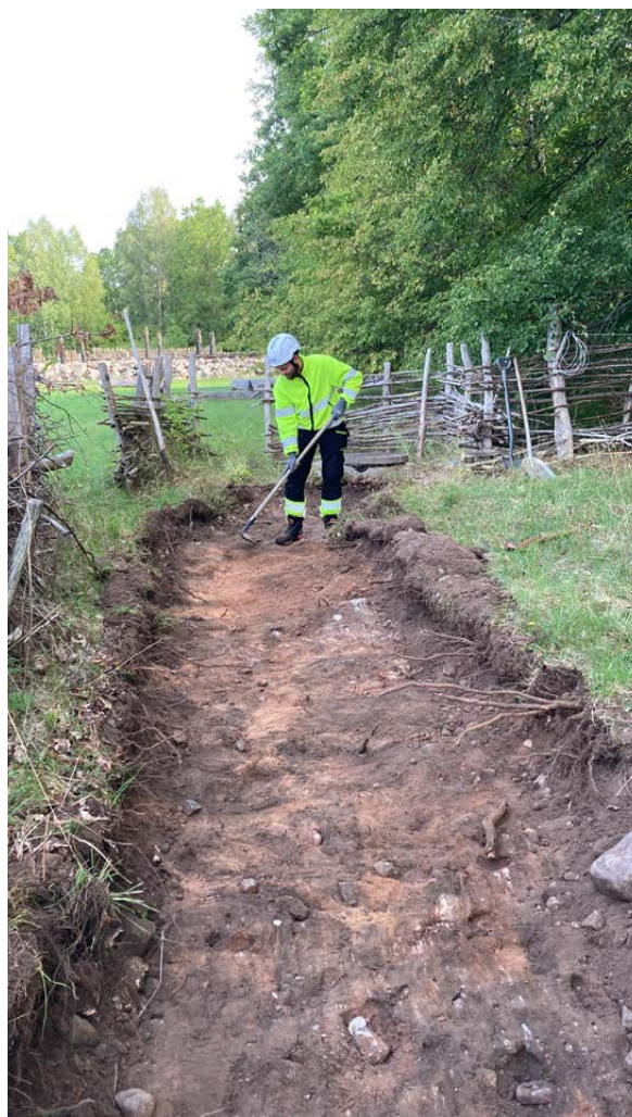
Figur 21. Nordligaste delen av norra schaktet angränsade mot Skäftekärrs rekonstruerade järnåldershusområde. Fotograferat från söder.
