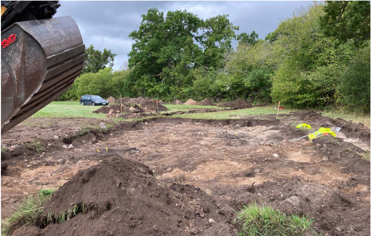
Figur 4. Schakt för byggnad. Till höger i bild syns ett smalare ledningsschakt. Fotograferat från öst.
