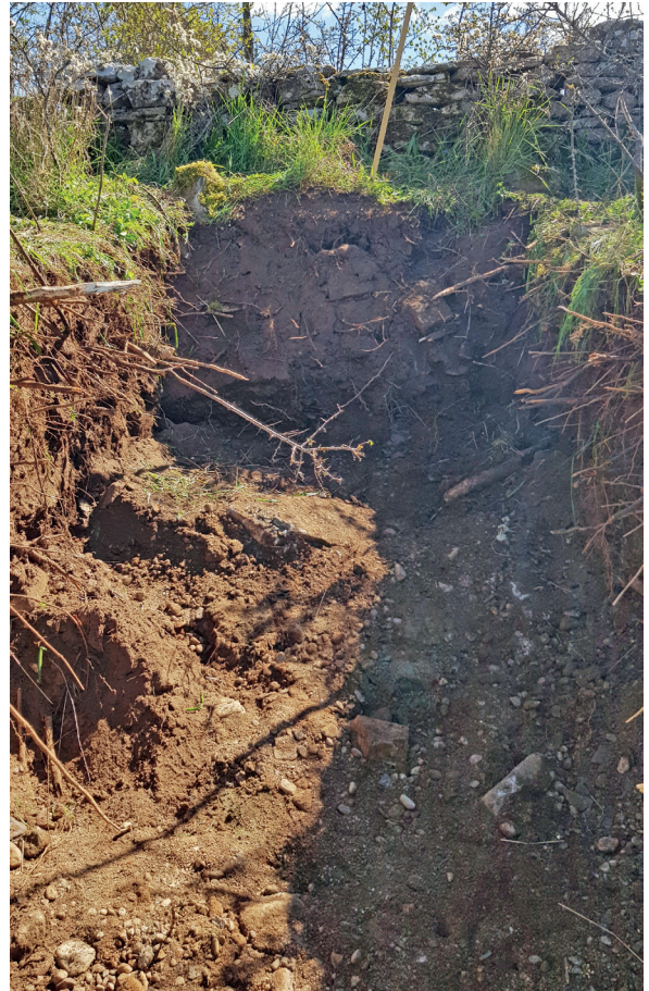
Figur 7. Schakt i områdets östra del. Fotograferat mot öst.
