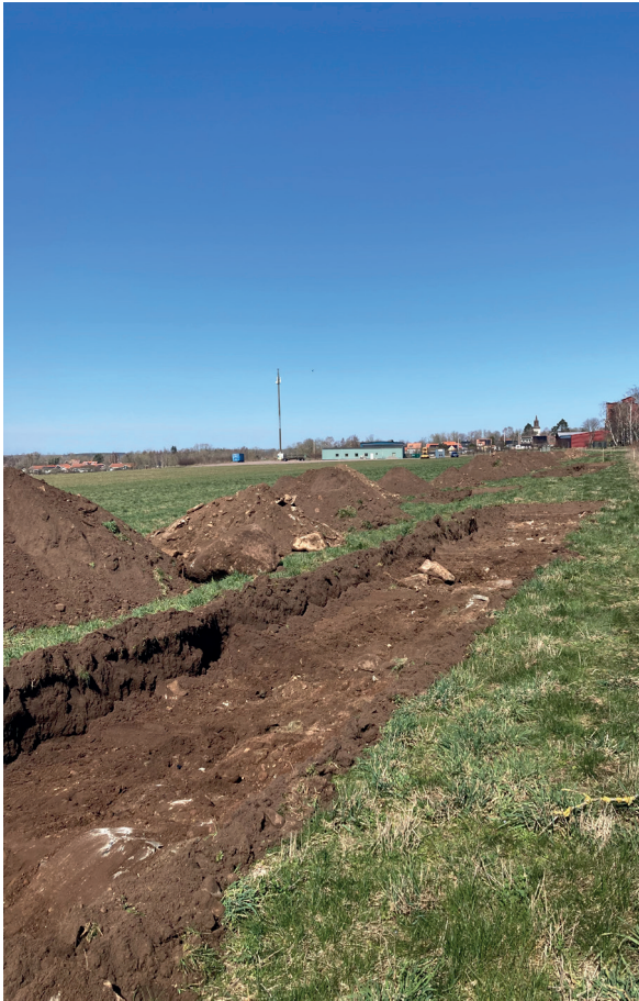
Figur 5. Den schaktade ytan sedd från mellersta delen. Fotograferat mot nordväst.
