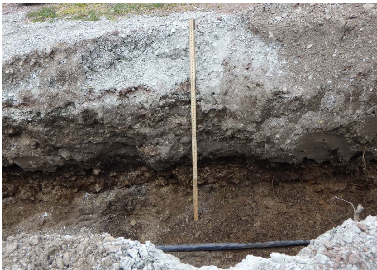
Figur 10. Rester av klapperstenslagret/kulturlagret i schakt 5. Foto från Ö.
