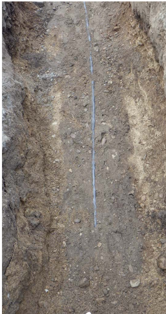
Figur 2. Det smalare äldre schaktets syntes i botten av det "nya". Foto från N.
