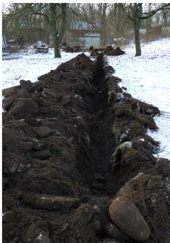
Figur 9. Det var rikligt med sten i ledningsschaktet i det södra området.
