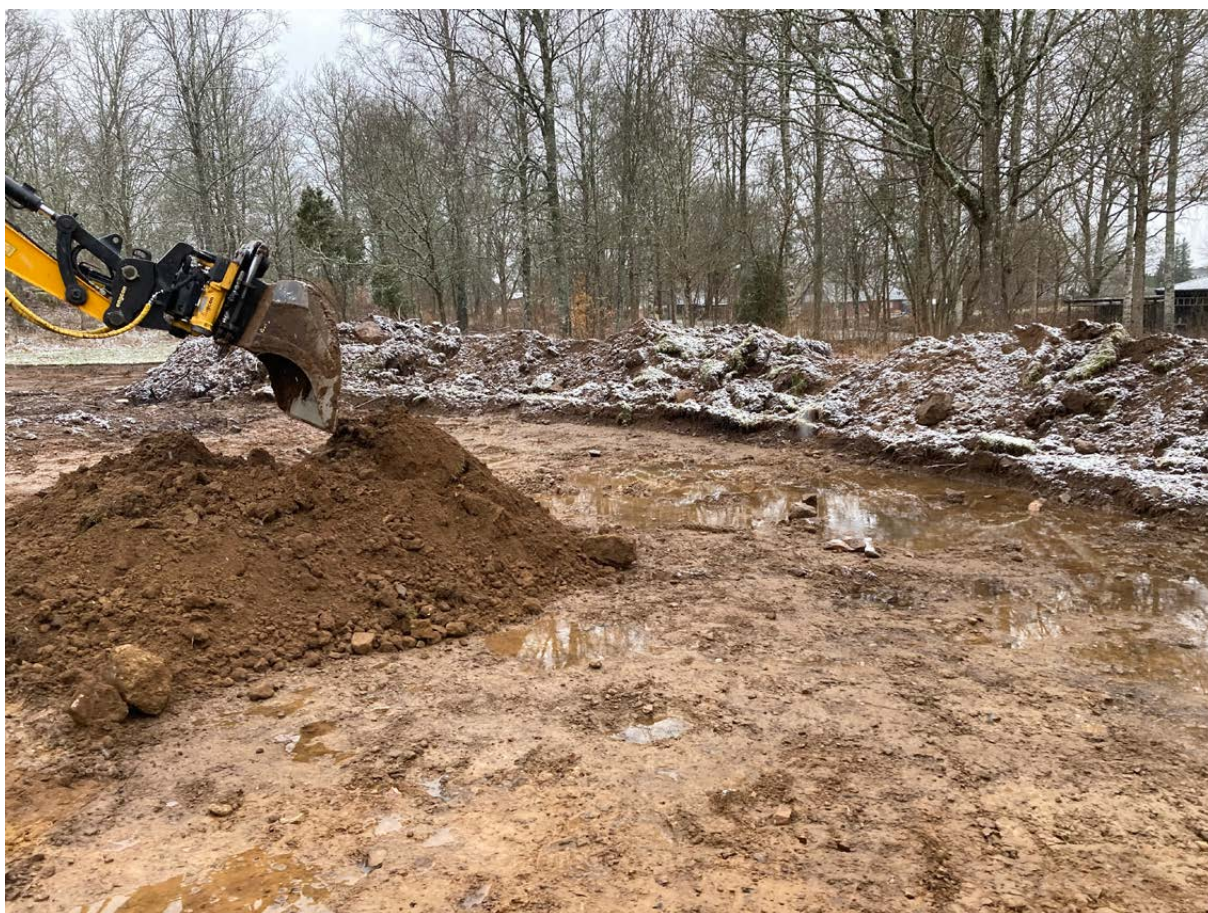
Figur 3. Schaktning i områdets nordöstra del. Fotograferad från syd
