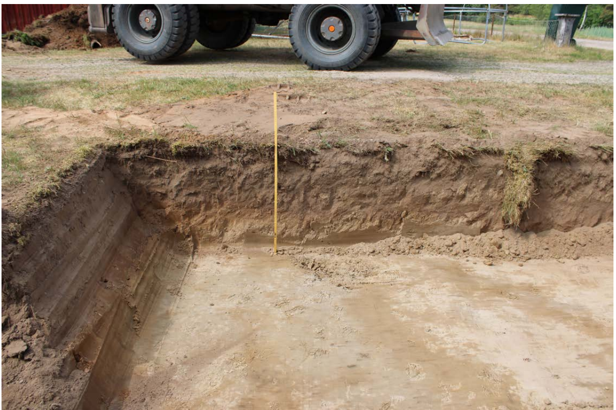
Figur 5. Profilväggen i den västra delen av schakten. Denna bestod av torv, matjord och ren sand. Foto från NO.
