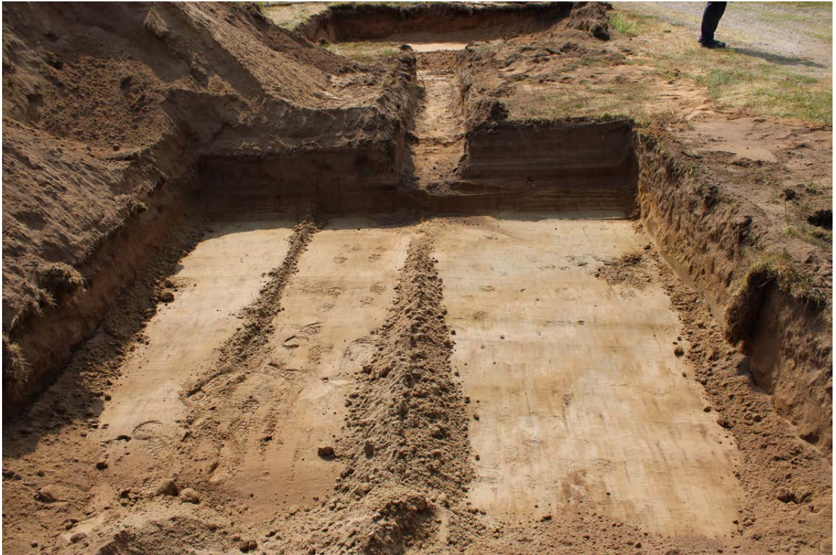
Figur 4. Foto över de schaktade ytorna. Foto från NNV.
