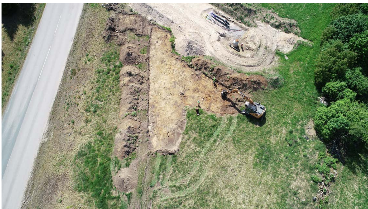
Figur 59. Schakt 56 öppnades upp i gårdstomtens SV del. Drönarfoto från N. Foto: Andreas Emilsson.
