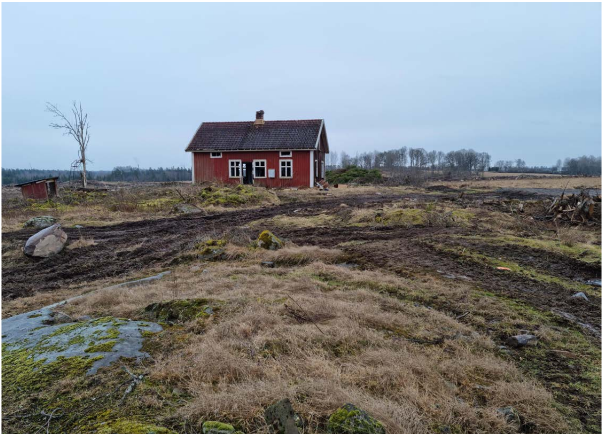
Figur 57. Delar av UO inom gårdstomten vid Ekalund var påverkat av markskador som uppstått i samband med avverkning inför undersökningen. Foto från NV. Foto: Andreas Emilsson.
