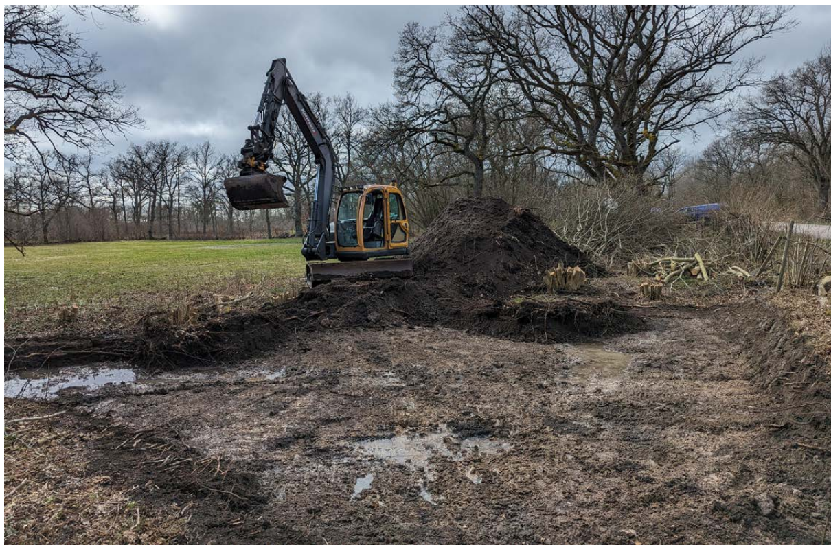
Figur 7. Ytan för bormaskinen banades av vid andra tillfället på plats. Foto från Ö.
