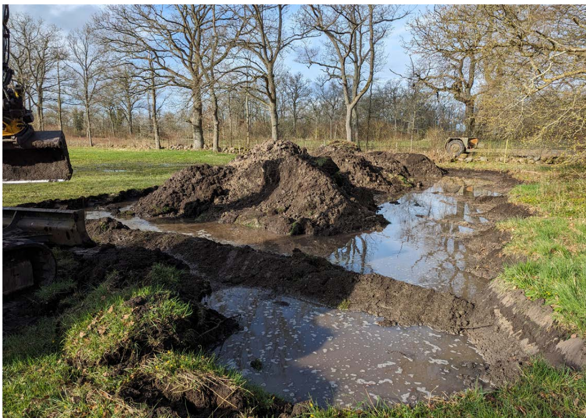
Figur 8. Vattnet trängde snabbt upp och vattenfylldde schaktet. Foto från Ö.
