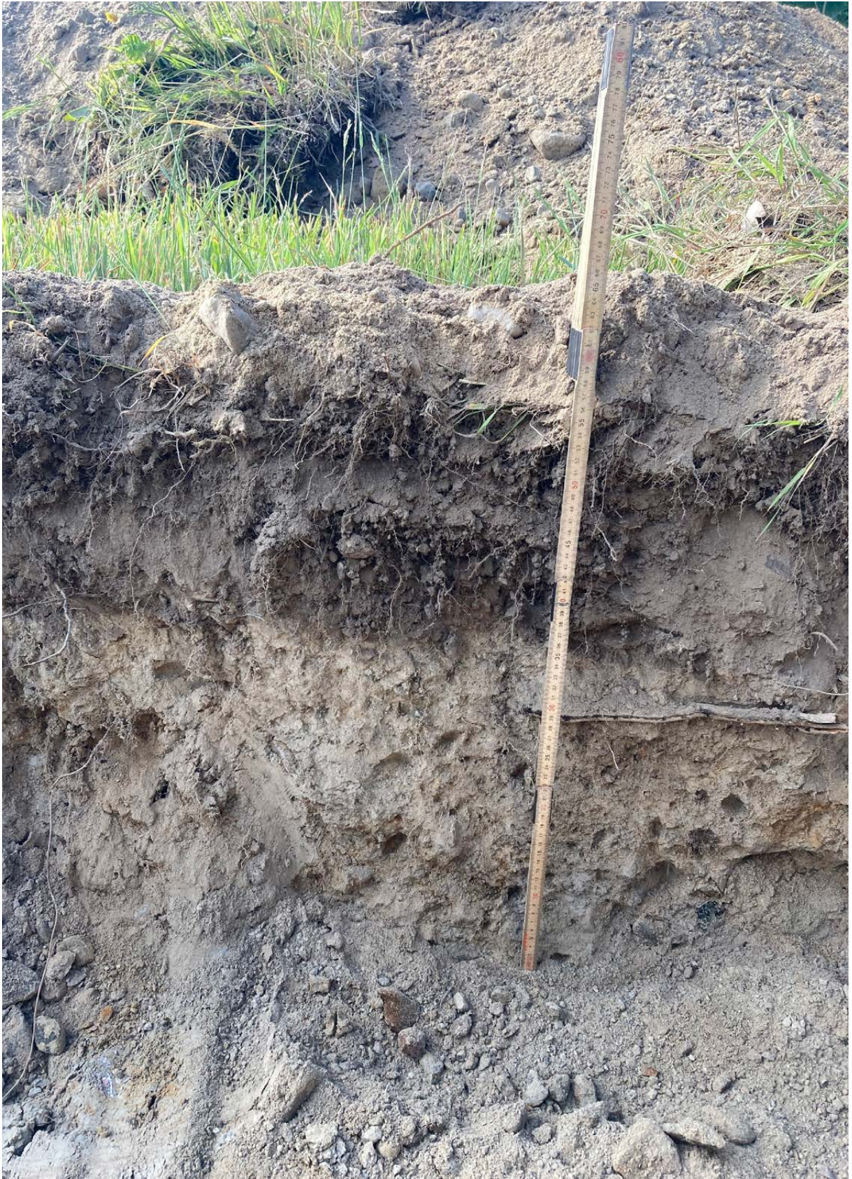
Figur 5. Schaktet bestod av matjord och vid schaktningstillfället en mycket torr silt.
