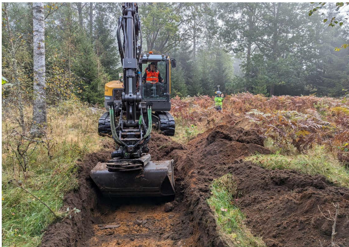
Figur 17. Schaktning inom delområde 2. Foto från Ö.
