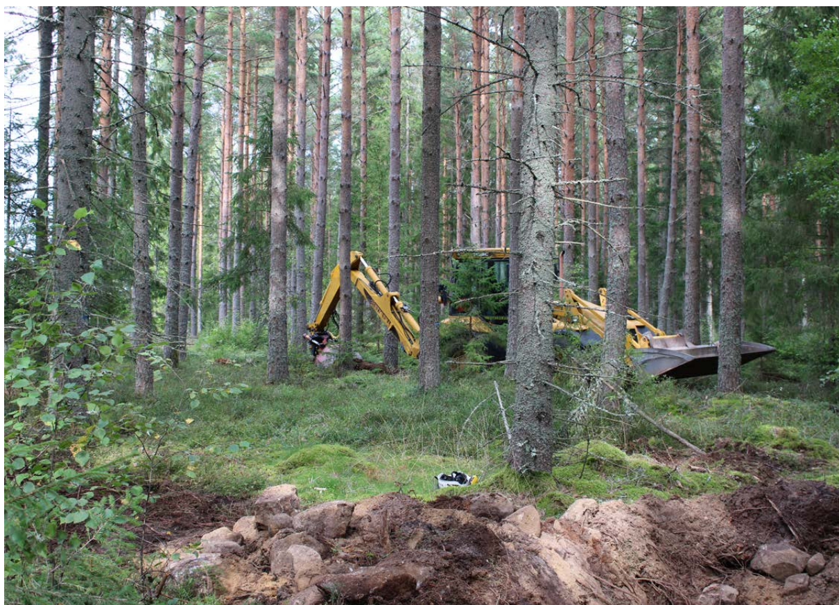
Figur 1. Schaktningen genomfördes på de ytor där maskinen kunde komma åt mellan träden. Foto från S.
