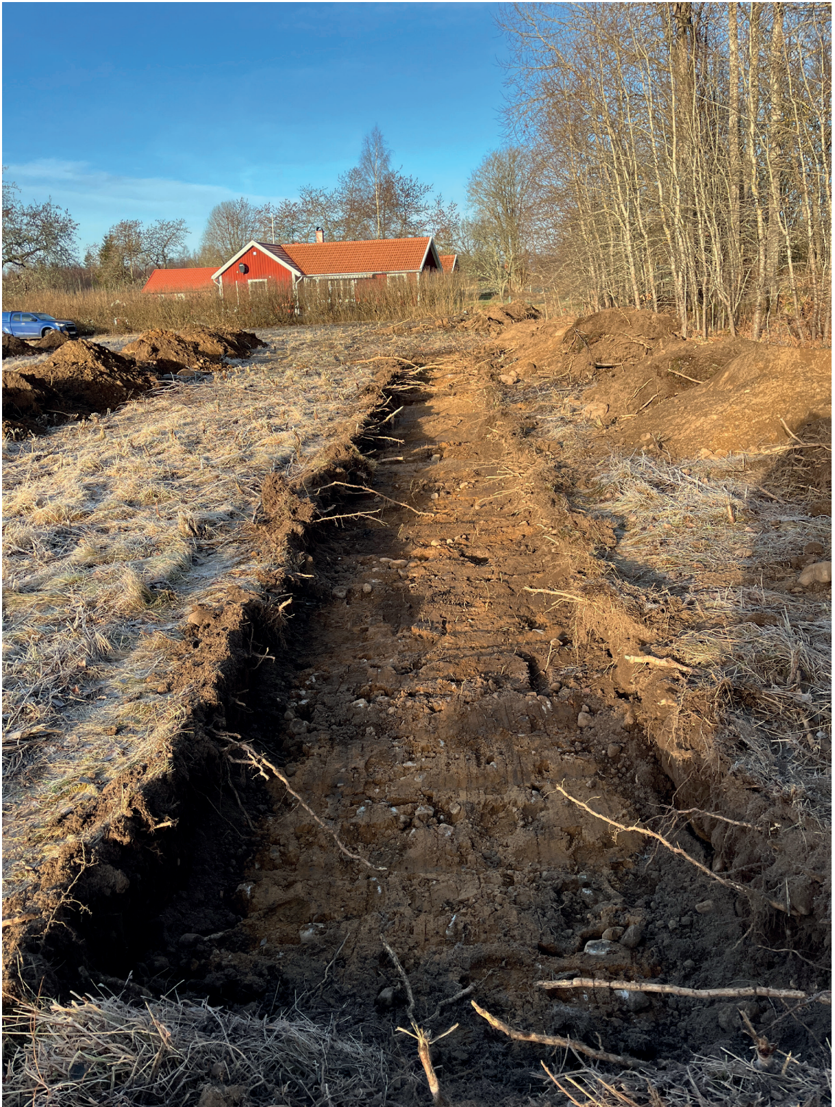
Figur 3. Schakt S2 sett från söder.
