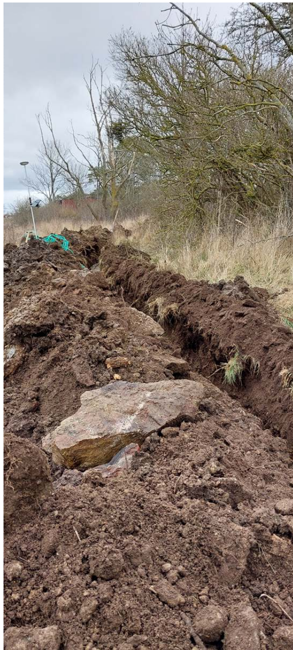
Figur 5. Schakt som undersöktes i kanten mellan stenmur/buskparti i öster och dike i väster. Foto från S.
