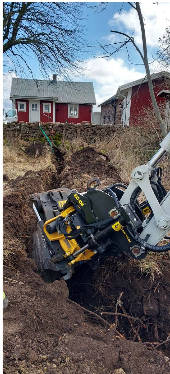
Figur 3. I bakgrunden syns stenmuren där ledningen trycktes under. I förgrunden syns den norra delen av schaktet som undersöktes. Foto från V.
