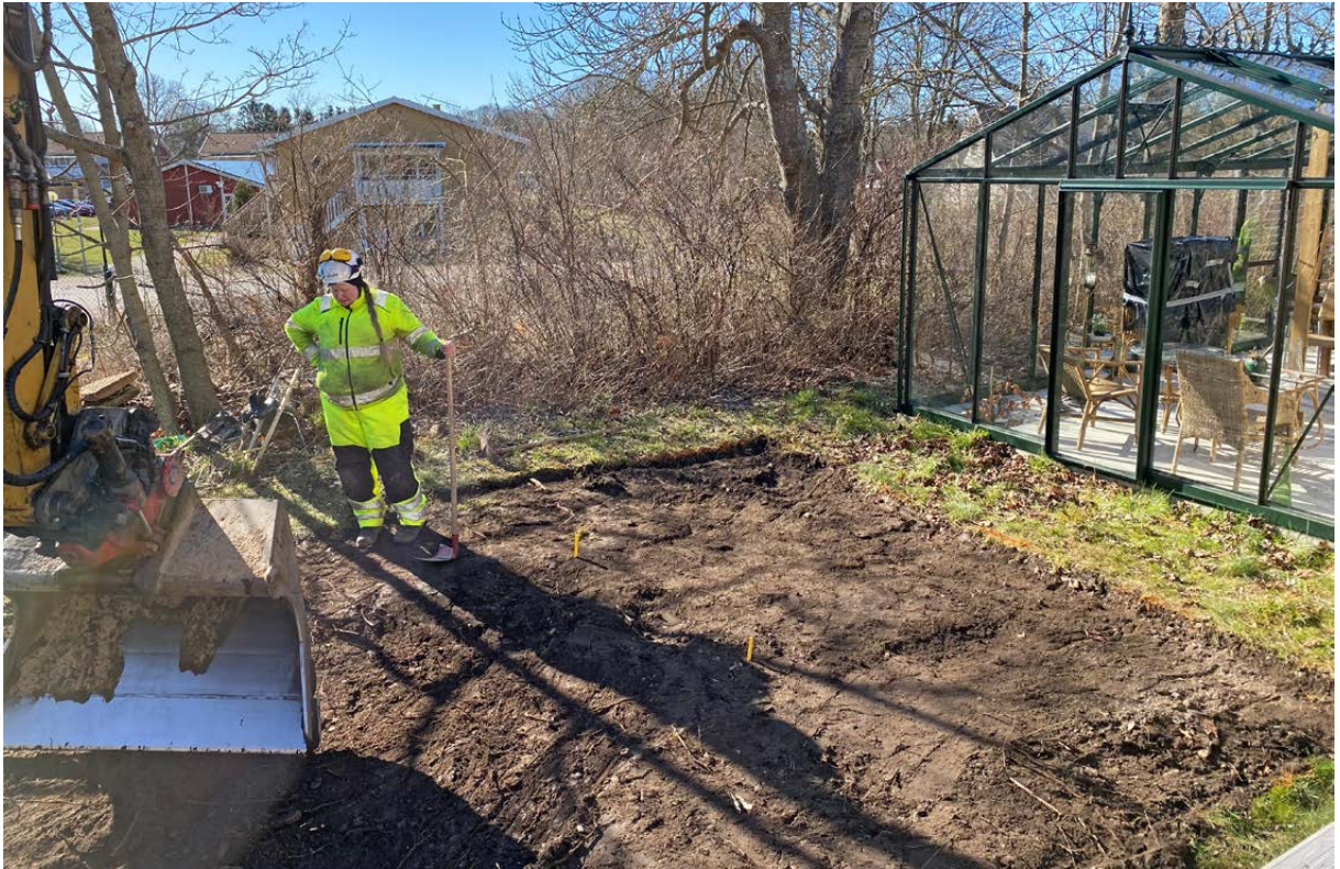
Figur 6. Ett schakt grävdes diagonalt över ytans västra del. Sandra Lundholm inleder schaktning. Foto från NO.
