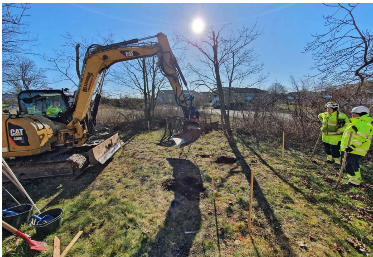
Figur 5. Schaktning inleddes efter att tre halvmetersrutor grävts för hand. Foto från NV.
