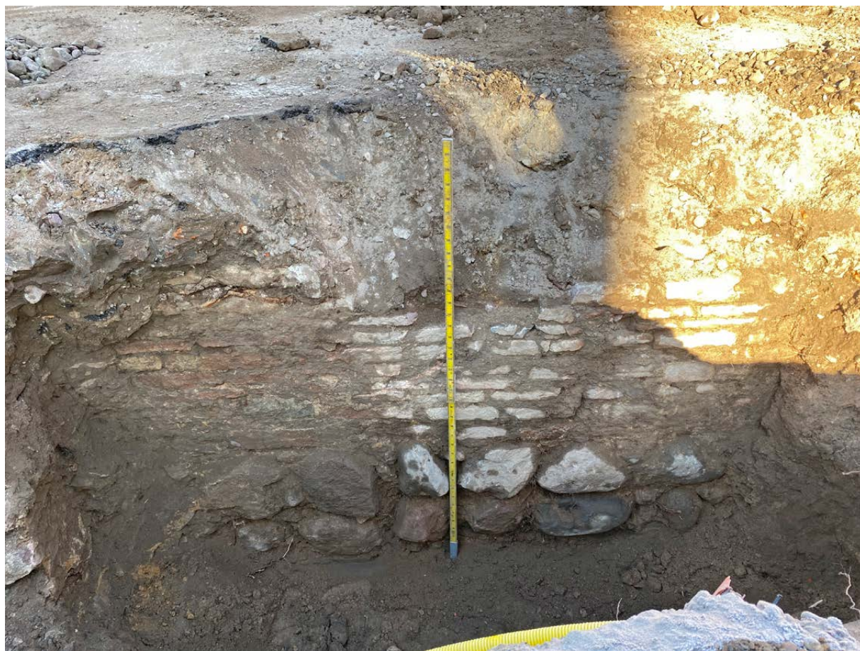
Figur 5. Den påträffade muren var byggd i kalksten och lagd på en kallmurad gråstenssula i två skift. I bild syns tydligt färgskillnaderna mellan kalkstensskivorna i den västra respektive mittersta och östra delen av muren, dvs. till vänster och höger. Foto från SO.
