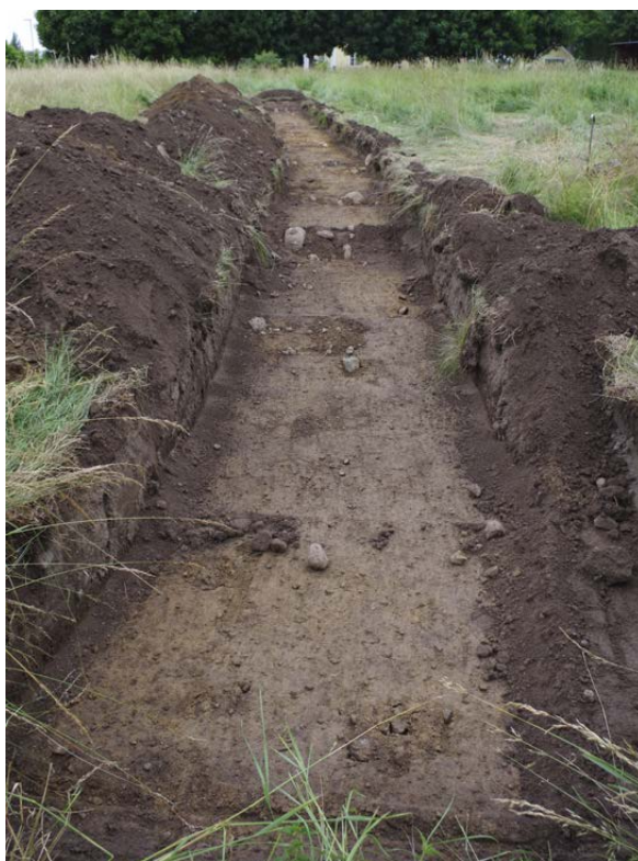
Figur 14. Schakt 19 efter avbaning, foto från söder.
