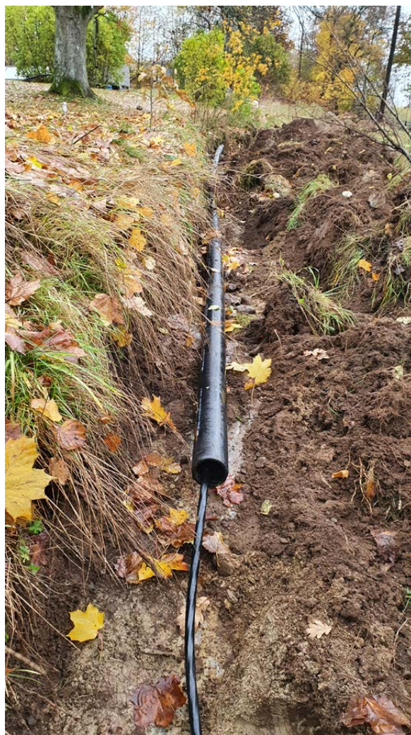
Figur 2. Högspänningsskabeln lades ner med plastskydd där berggrund hindrade schaktning ner till 0,6–0,7 m.
