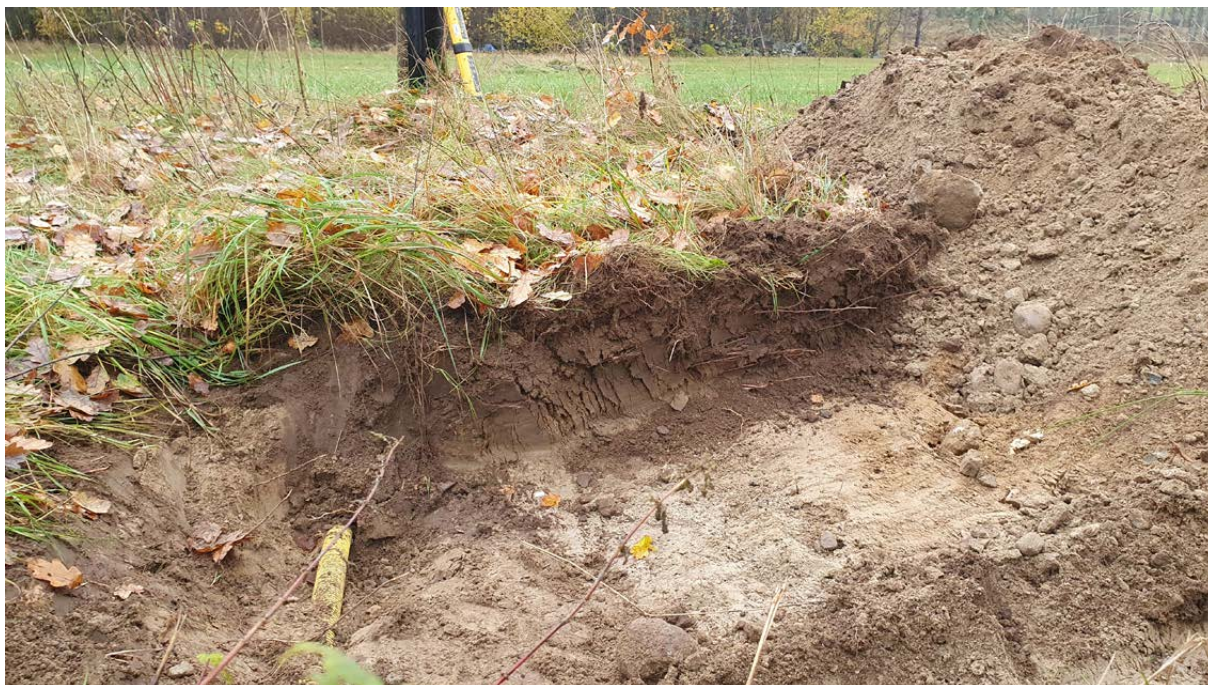
Figur 3. Schaktning längs åkern i Alvesta Blädingeås 2:3 där den nedgrävda högspänningsledningen skulle ersätta luftledningen. Elstolpen som syns i bakgrunden togs bort av exploatören. Schakten i området visar ett tjockt matjordslager som låg ovanpå en steril morän. En befintlig naturgasledning (skyddad av ett gult plaströr) syns i schaktet.
