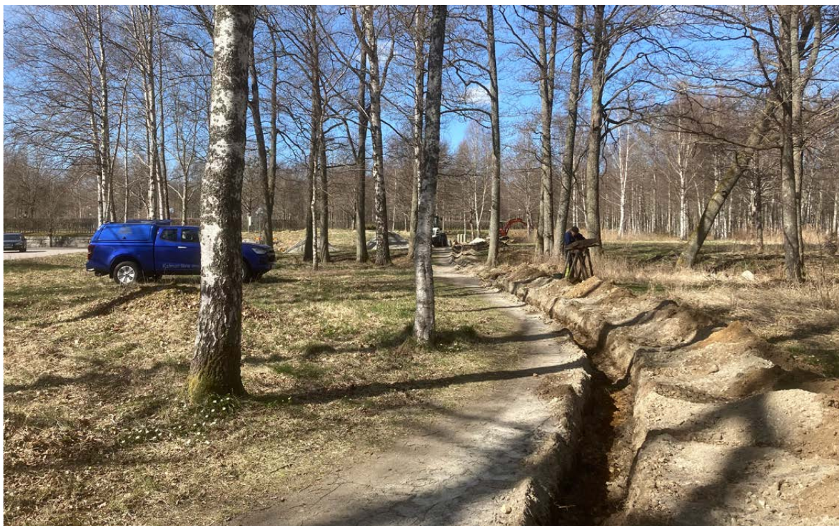
Figur 6. Schaktet längs promenadstigen, foto taget från söder.
