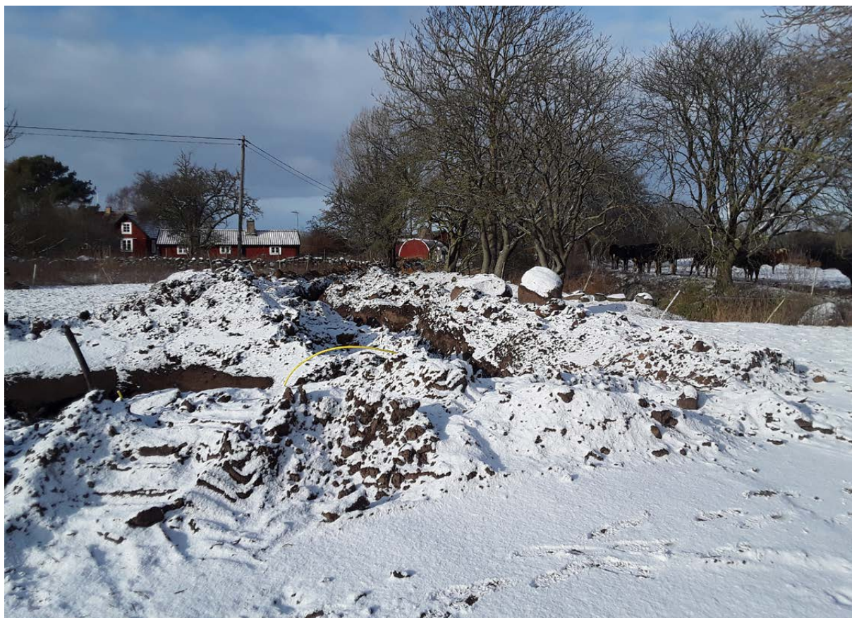
Figur 3. Vissa dagar snöade det rikligt och snön lade sig i schakten. Foto från söder.
