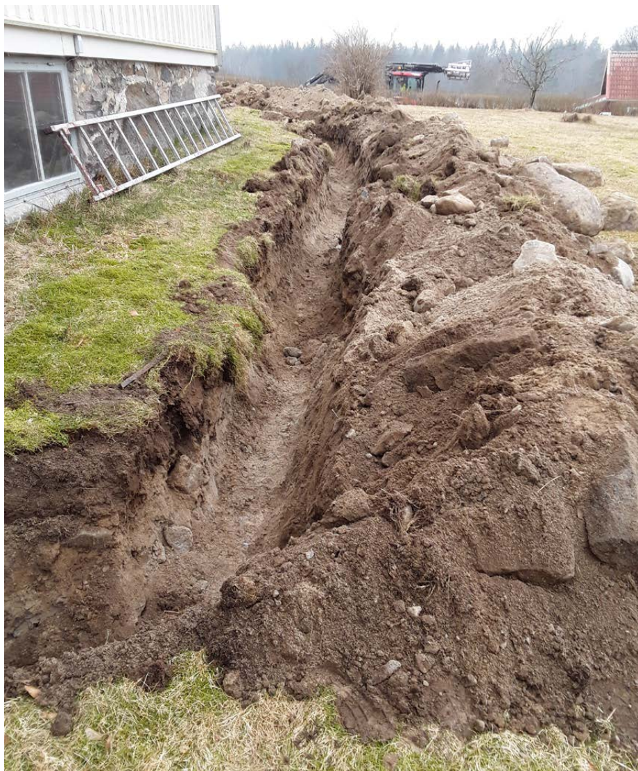
Figur 4. Schaktet väster om huset. Överst var ett tunt matjordslager och därunder sandig morän.
