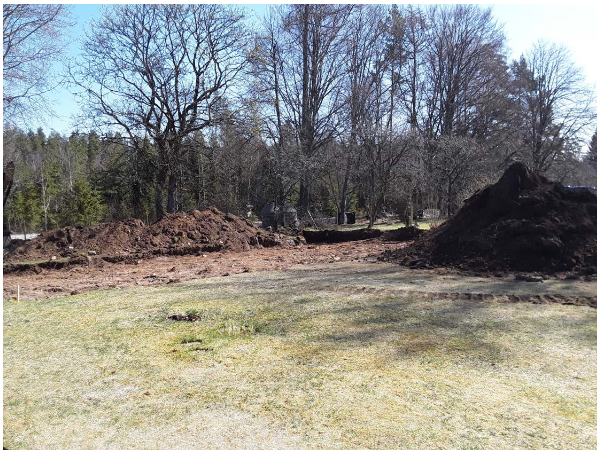
Figur 4. Schaktet för huskroppen fotograferat från SSV.
