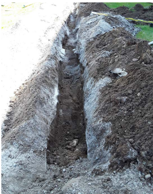
Figur 6. Foto på schaktet norr om kyrkan. Foto från väster.
