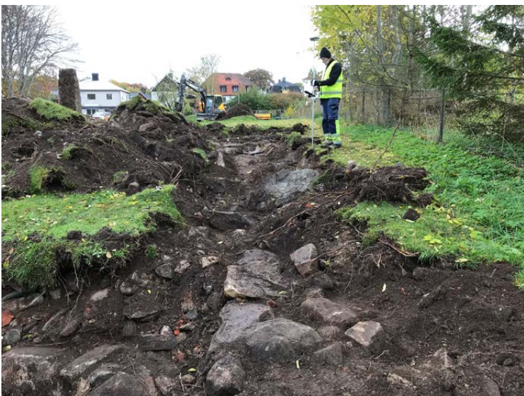
Figur 11. Murhörn i schakt 16. Fotograferat från väst.
