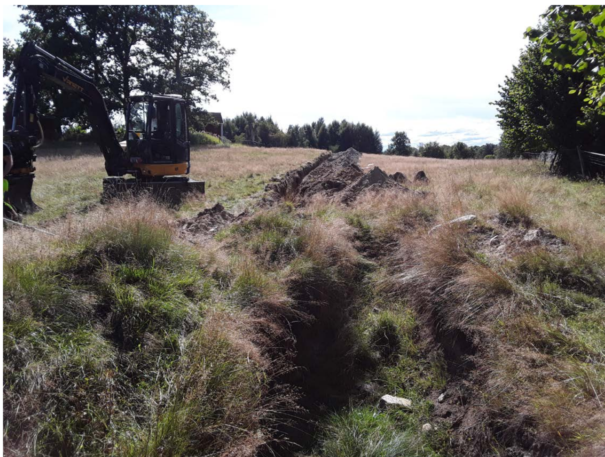
Figur 4. Foto på schaktet taget från norr.
