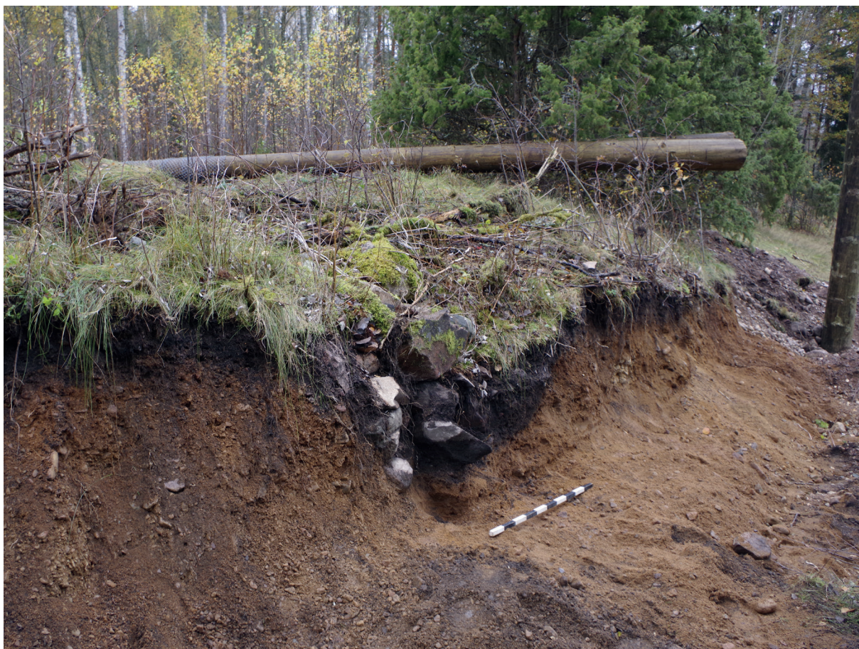
Figur 6. Jordkällare A1 och delar av den schaktade ytan vid ledningsarbetet. Foto från norr.
