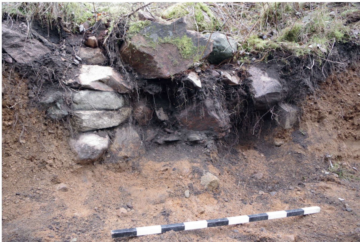
Figur 7. Den framrensade ingång där den vänstra kanten är intakt och kallmurad. I botten finns bitvis ett gråare lager med småsten som möjligen kan utgjort ett golvlag. Foto från väster.
