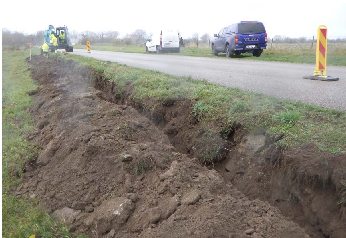
Figur 4. Foto på del av schaktet taget från väster.
