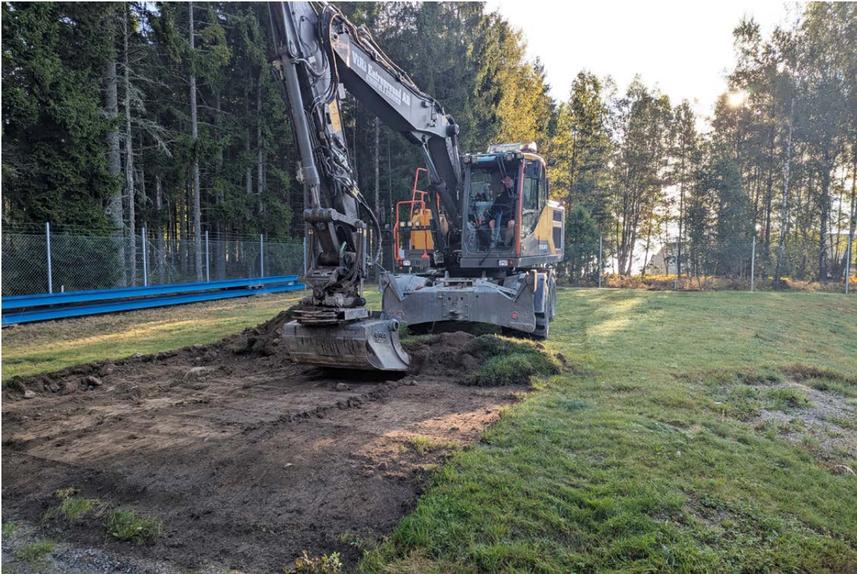
Figur 5. Påbörjad avbaning av Yta 1. Foto från väster.
