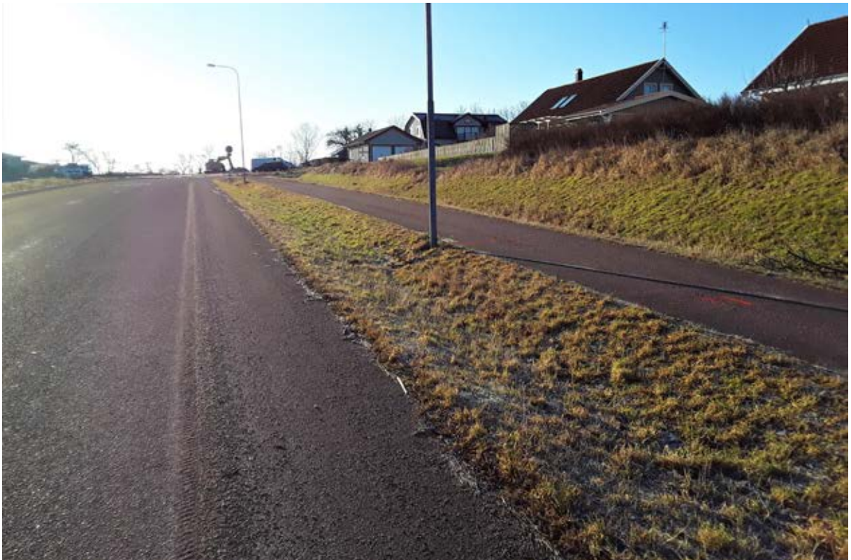
Fig 5. Provschakt togs upp i den södra slänten till cykelbanan (till höger i bild). Foto från NV.
