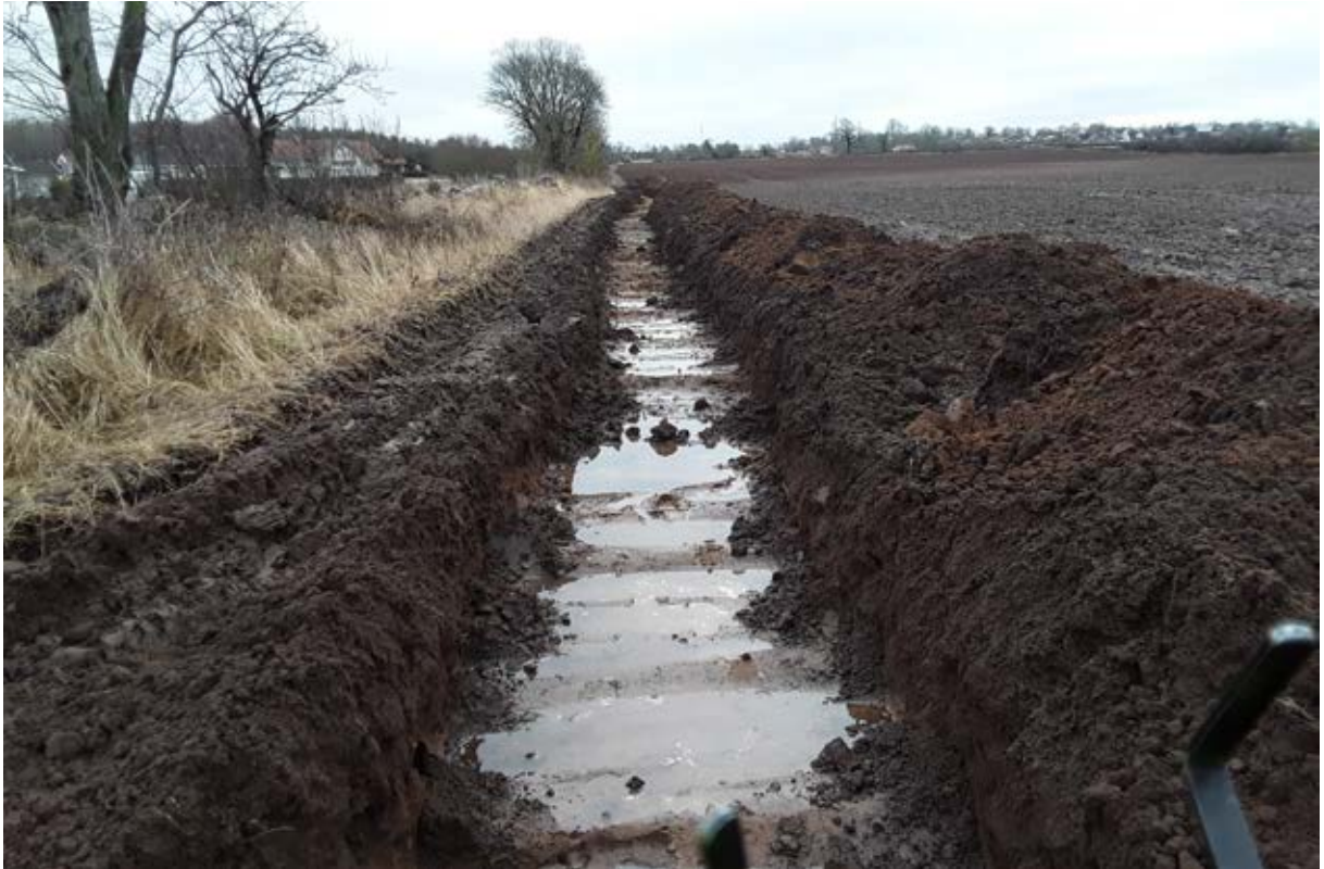
Fig 4 Foto över schakt 1 från NV.
