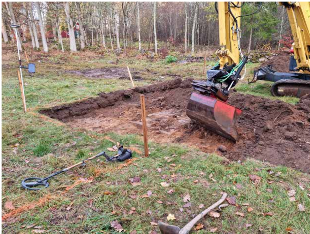
Figur 5. Pågående schaktning. Foto från sydöst.
