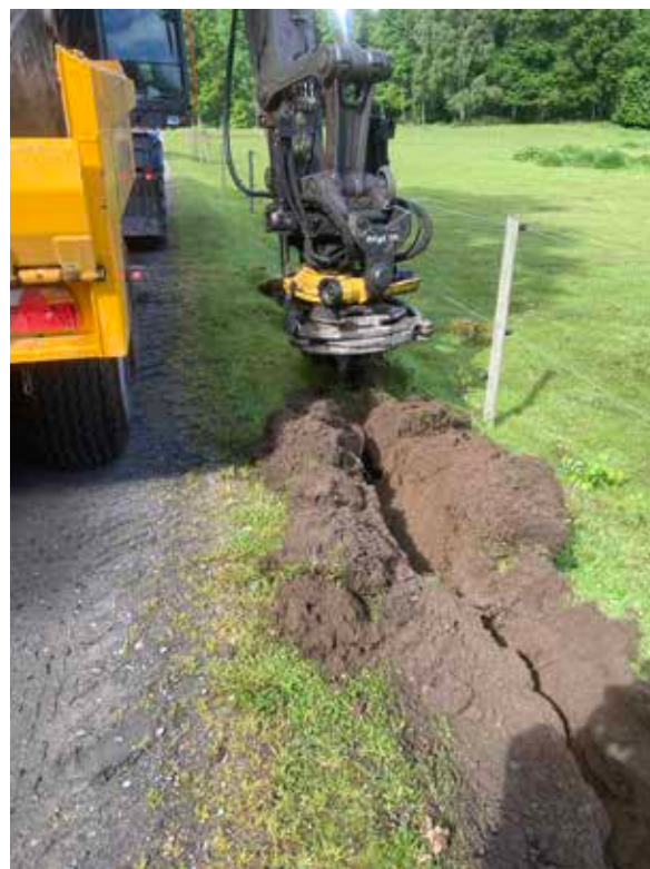
Figur 4. Plöjning för fiberdragningen var den metod som användes mest under projektet.
