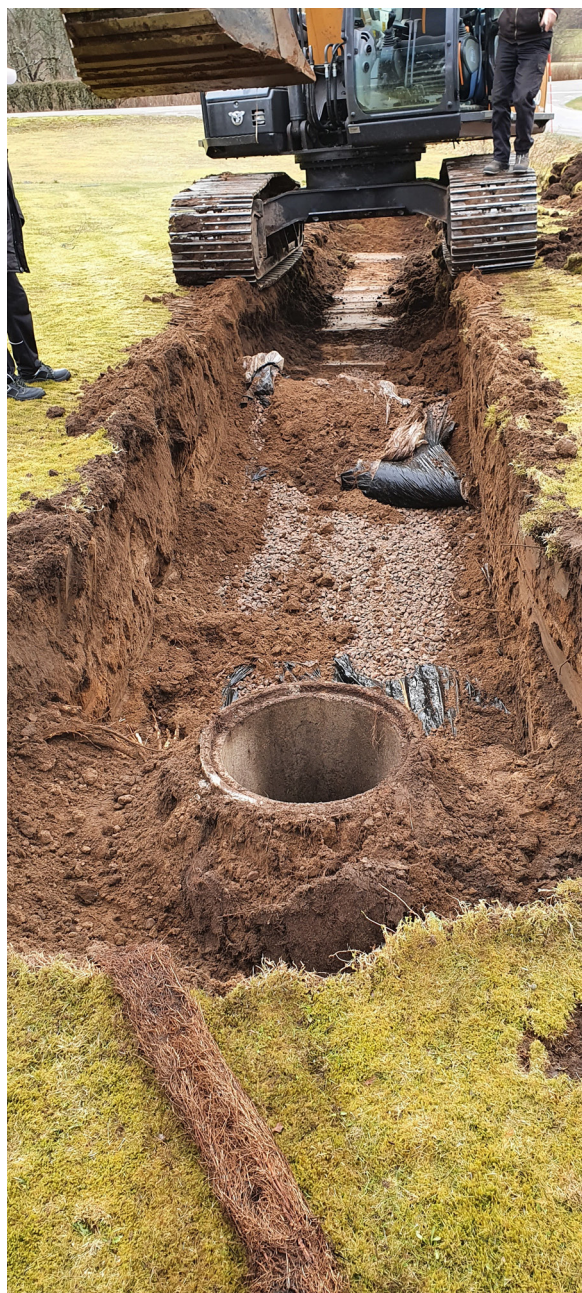
Figur 5. Bädden till det tidigare nedgrävda avloppet. Fotot från V.
