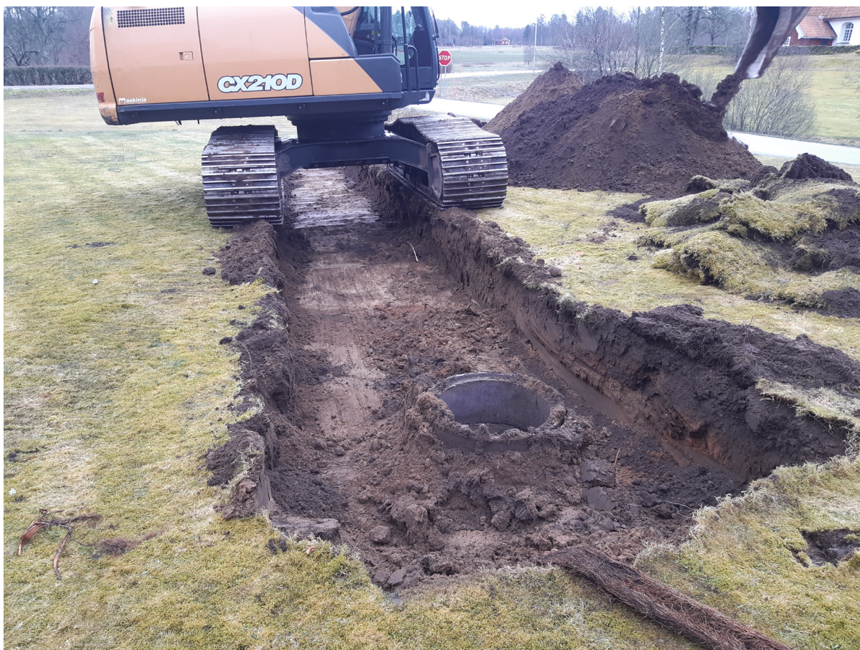
Figur 3. Schaktet för infiltrationen grävdes ner skiktvis. Efter varje nergrävt skikt gjordes en metalldetektering och översiktlig rensning. Foto från V.
