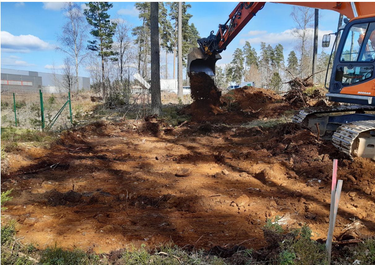
Figur 3. Ytan friläggs med grävmaskin. Foto från sydväst.
