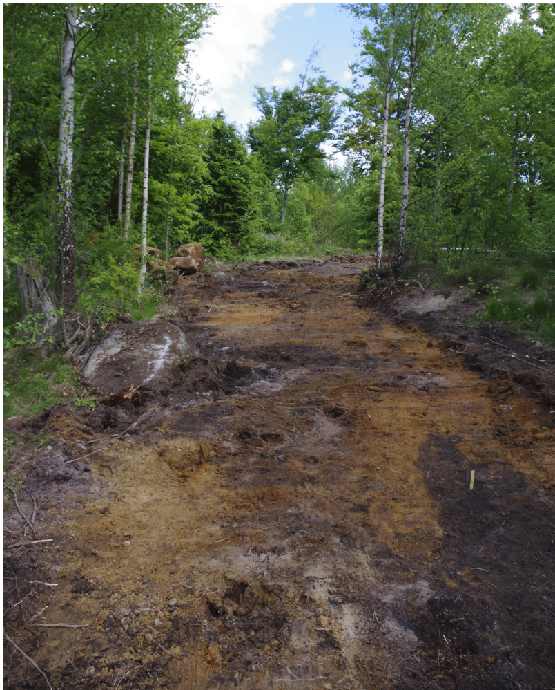
Figur 3. Översikt västra delen av schakt. Foto taget från väster.
